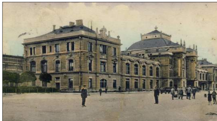
Nádražní ulice s novou nádražní budovou, poč. 20. st.
