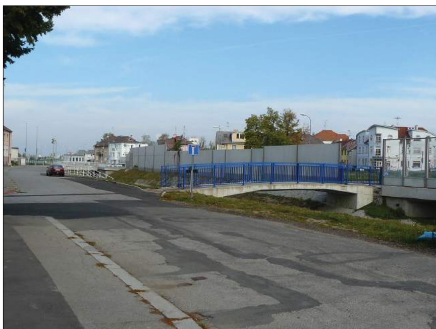
ulice Vodní s protihlukovými stěnami
