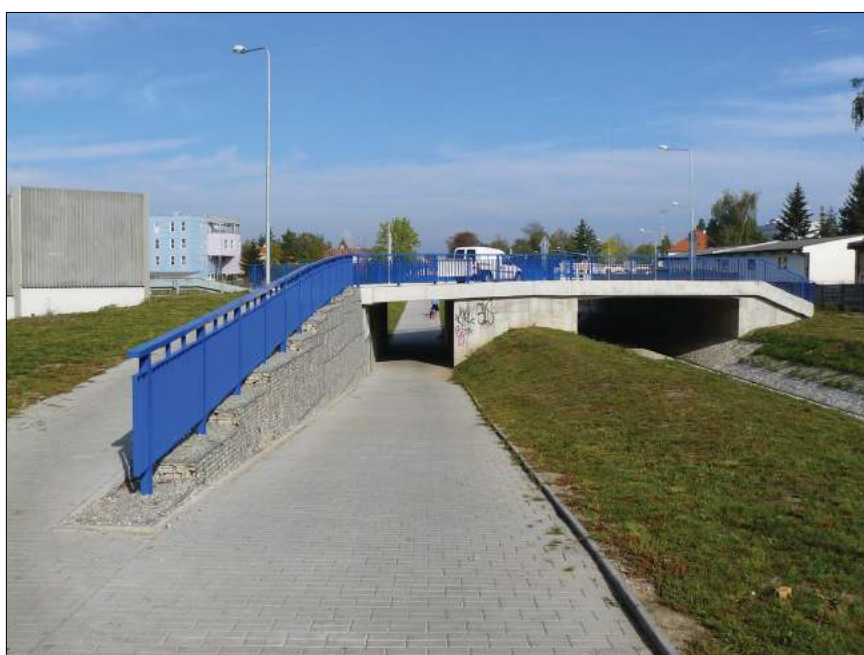
podchod pod Vodní ulicí
