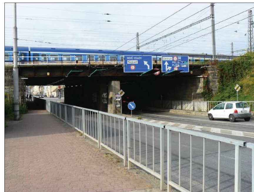
viadukt pod trať na Rudolfovské ulici
