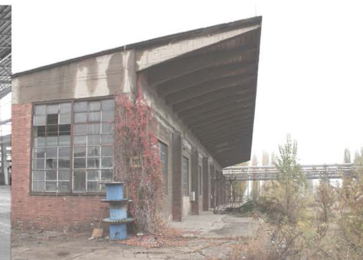
STÁVAJÍCÍ STAV AREÁLU
