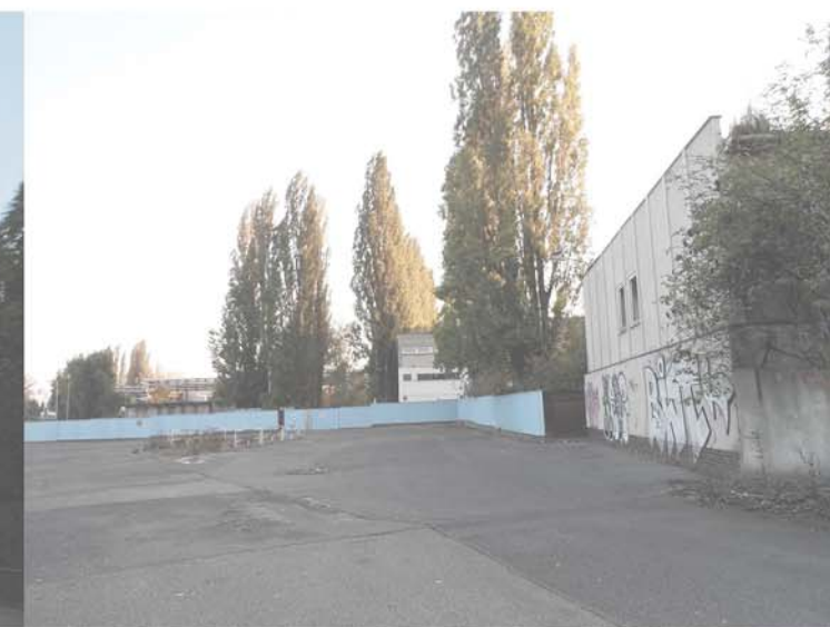
STÁVAJÍCÍ STAV AREÁLU
