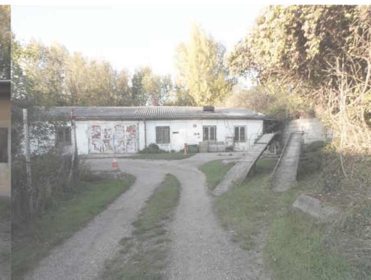
STÁVAJÍCÍ STAV AREÁLU
