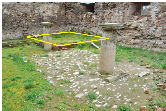
Obrázek 55: Oblast s dochovanou podlahou ze skládaného lomového kamene, žlutou čarou vyznačena oblast s novodobější cihelnou podlahou z větší části prorostlou mechem a travou, foto: autor, duben 2016
