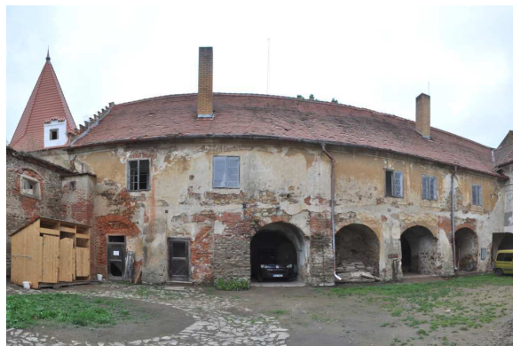
Obrázek 7: Pohled na severní křídlo z II. nádvoří foto: autor, březen 2016
