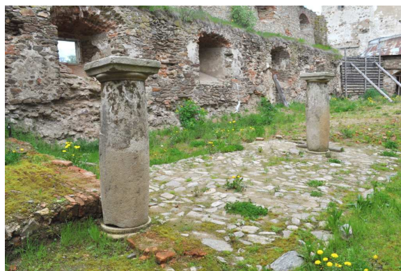
Obrázek 50: Detail dvou in-situ dochovaných sloupů, původně podpírajících klenby přízemí, foto: autor, květen 2016
