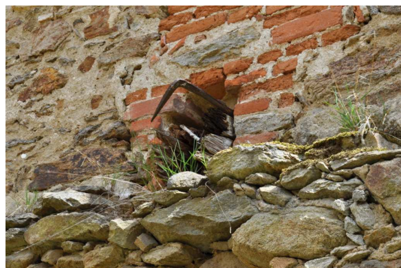
Obrázek 52: Oblast uložení dřevěných táhel, na snímku lze spatřit ocelovou kleštinu a dochované zhlaví dřevěného táhla, foto: autor, květen 2016
