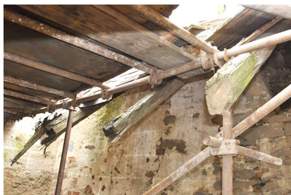
Obrázek 111: Pohled na degradované pozůstatky krokví zastřešení vstupního prostoru, foto: autor, duben 2016
