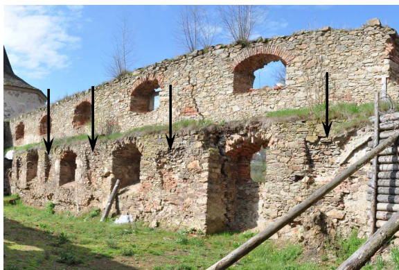
Obrázek 51: Pohled na vnitřní líc obvodové stěny, šipky znázorňují polohu kapes, do kterých byly uloženy klenby přízemí, foto: autor, duben 2016
