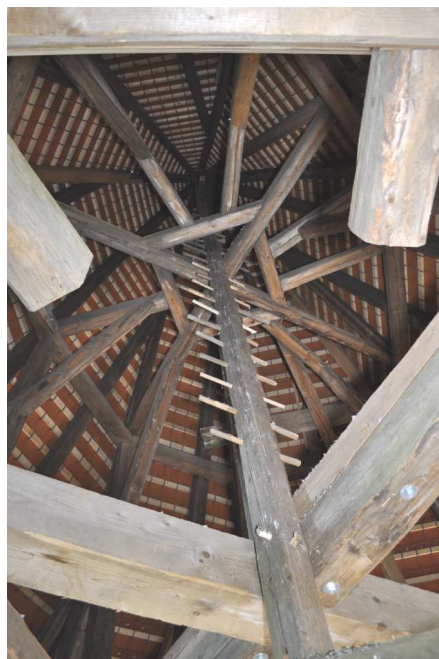
Obrázek 46: Pohled do krovu SZ bašty, viditelný je druhý základový kříž, pod ním servisní žebřík pro údržbu krovu, foto: autor, duben 2016
