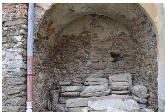
Obrázek 9: Přízemí severního křídla, rozhraní stavebních fází výstavby objektu, dobře patrná je struktura zdiva, foto: autor, duben 2016
