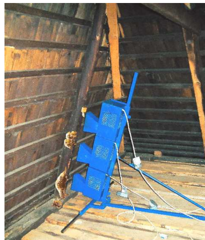
Obrázek 138: Ošetření konstrukcí napadených dřevomorkou mikrovlnným zářením, ilustrační foto, zdroj: www.drevostavby.cz
