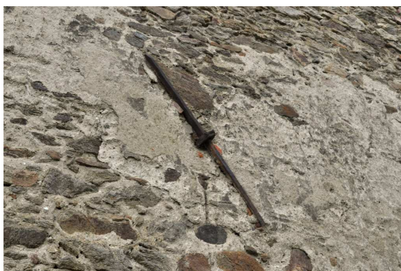
Obrázek 53: Detail ocelové závlače z dvorního líce obvodové stěny konírny, foto: autor, květen 2016
