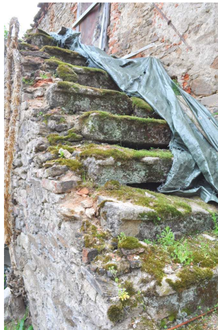
Obrázek 102: Pohled na degradované kamenné stupně, obrostlé navíc silnou vrstvou mechu, foto: autor, květen 2016
