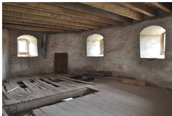
Obrázek 32: Plochostropé prostory bašty s dřevěnými trémovými stropy, foto: autor, duben 2016
