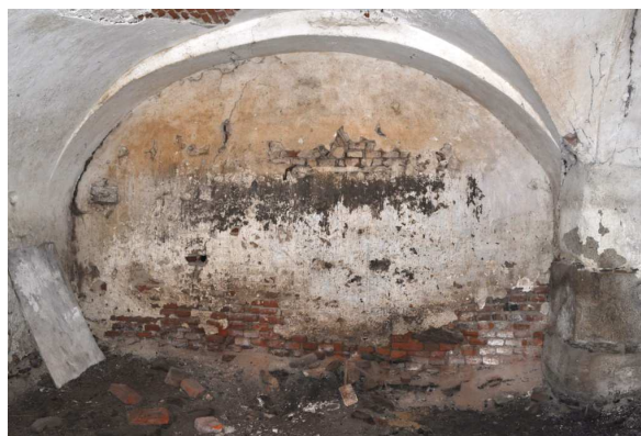
Obrázek 11: Přízemí severního křídla, dělicí příčka z cihelného zdiva, foto: autor, srpen 2015
