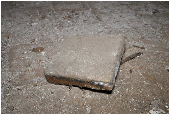
Obrázek 37: Detail dlažby z cihelného střepu, tzv. „půdovky“ v přízemí bašty, foto: autor, duben 2016
