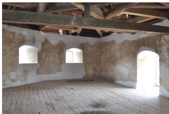
Obrázek 42: Obnovené omítky 2. patra SZ bašty, bílá místa značí doplňovanou omítku, foto: autor, duben 2016
