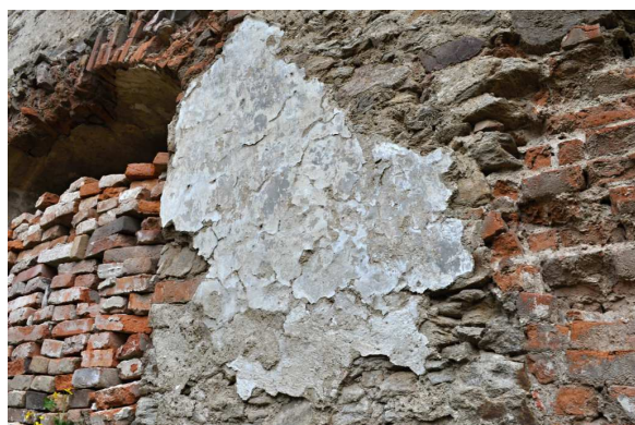
Obrázek 57: Fragment dochované vnitřní omítky bývalé konírny, foto: autor, květen 2016
