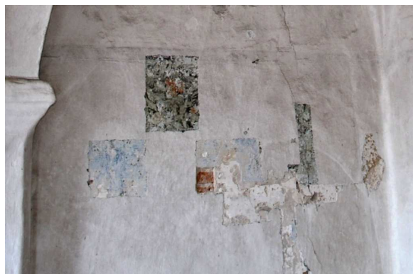
Obrázek 20: Restaurátorská sonda interiérových omítek nadměrně velkého rozsahu, foto: autor, duben 2016
