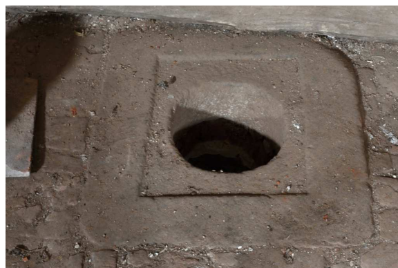
Obrázek 31: Severozápadní bašta, kamenný klenák s kruhovým otvorem, foto: autor, duben 2016
