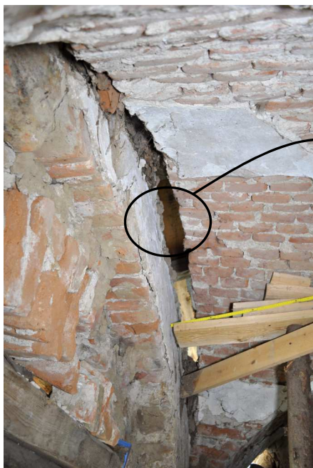
Obrázek 92: Odklon podpůrné stěny od čela klenby, šířka vzniklé mezery činí 11 cm, foto: autor, duben 2016
