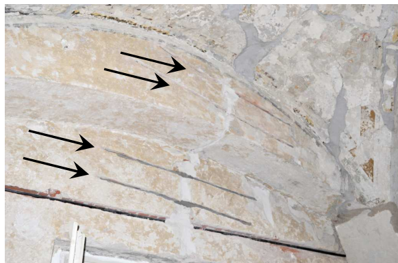
Obrázek 131: Sanace trhlin tzv. „stehováním“, ilustrační foto, foto: autor
