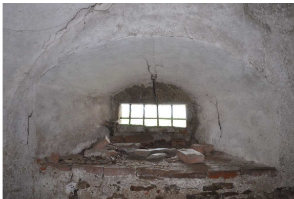
Obrázek 38: Pohled z interiéru na střílnový otvor v suterénu bašty, viditelné je kamenné ostění, rozevírající se špalety, zaklenuté nadpraží i cihelný parapet, foto: autor, duben 2016
