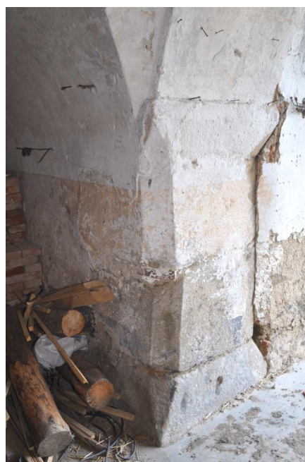
Obrázek 10: Kamenné kvádry podpůrných pilířů kleneb, foto: autor, duben 2016
