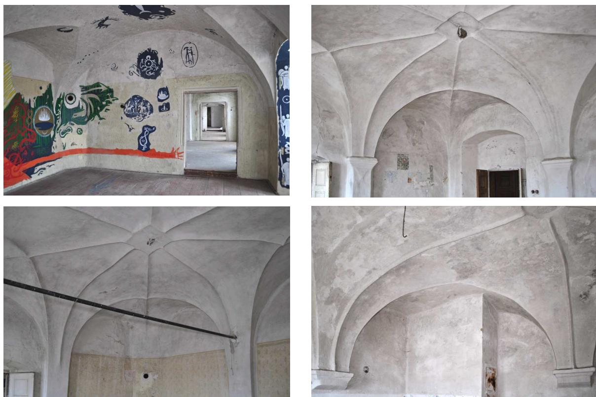
Obrázek 12: Příklad zaklenutí 1. patra, a) valená klenba s lunetami, b) křížová klenba s pilastry, c) křížová klenba s lizénami sepnutá táhlem, d) křížová klenba uložena na krakorcích, foto: autor, duben 2016
