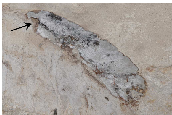
Obrázek 128: Proměny dřevomorky domácí s ročními obdobími, foto: autor,
