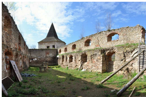
Obrázek 49: Pohled do vnitřní dispozice bývalé konírny, vpravo západní obvodová zeď se zřetelným ústupkem, v pozadí JZ bašta, foto: autor, duben 2016
