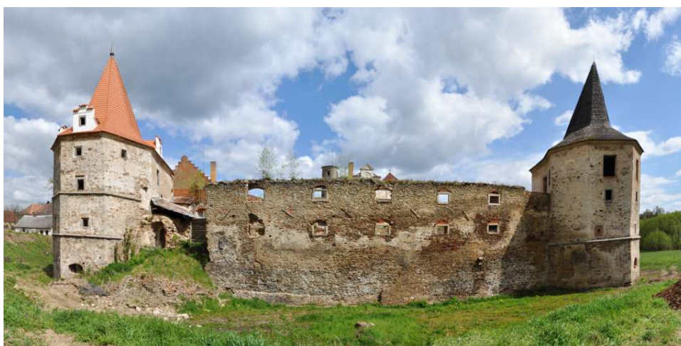
Obrázek 48: Pohled na objekt bývalé konírny a sýpky od západu, budova je vsazena mezi dvě polygonální bašty, foto: autor, květen 2016
