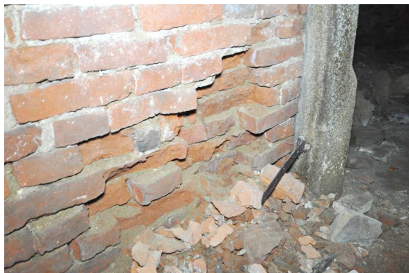
Obrázek 113: Odštípané části cihel ostění vstupu do suterénu bašty vlivem zmrazovacích cyklů, foto: autor, duben 2016
