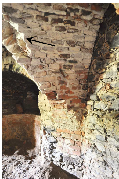
Obrázek 109: Šipka znázorňuje lokální absenci kusového staviva v žeburu klenby, foto: autor, duben 2016
