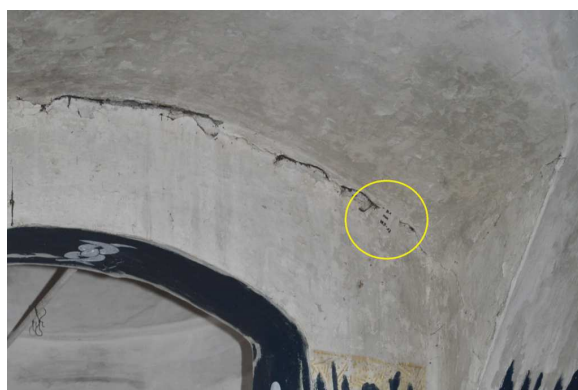
Obrázek 73: Ilustrace umístění sádrového terče, foto: autor, leden 2016
