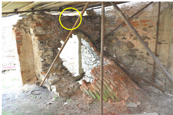
Obrázek 110: Chybějící část valené klenby nad schodišťovým prostorem, v kroužku je vyznačena poloha kapsy po dřevěném trámu, foto: autor, duben 2016
