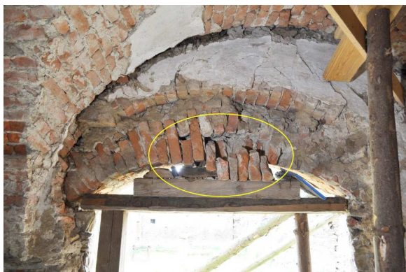
Obrázek 95: Uvolňování kusového staviva z klenutých nadpraží otvorů, foto: autor, květen 2016
