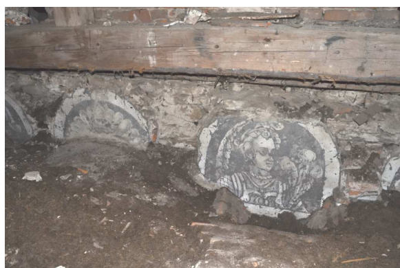
Obrázek 23: Lunetová výzdoba původně vnější fasády severního křídla, po dostavbě druhé části se výzdoba ocitla v podkroví, foto: autor, září 2015
