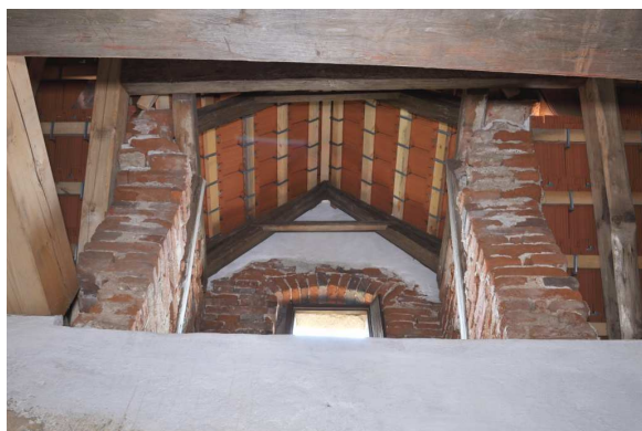
Obrázek 45: Pohled na konstrukci vikýře z interiéru SZ bašty, foto: autor, duben 2016
