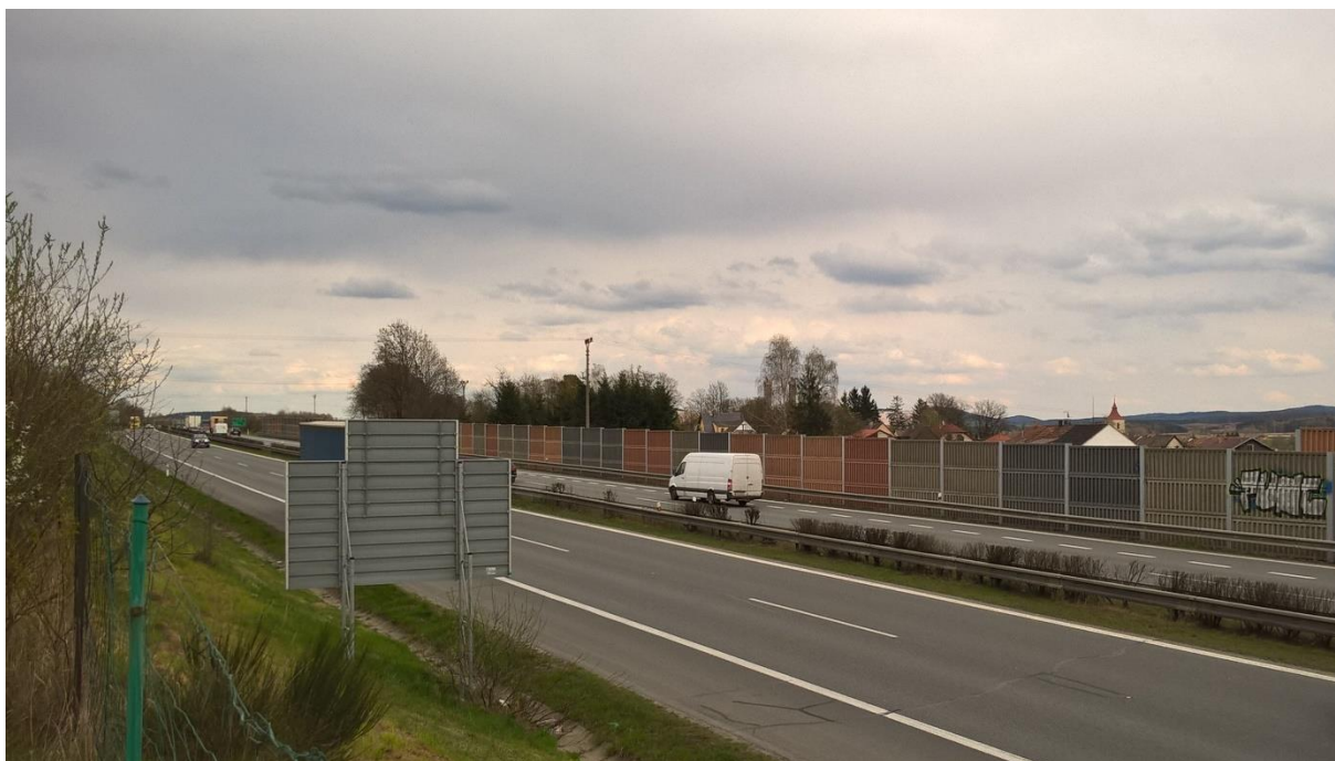
Obr. 16: Protihluková stěna podél dálnice D5 [3]
