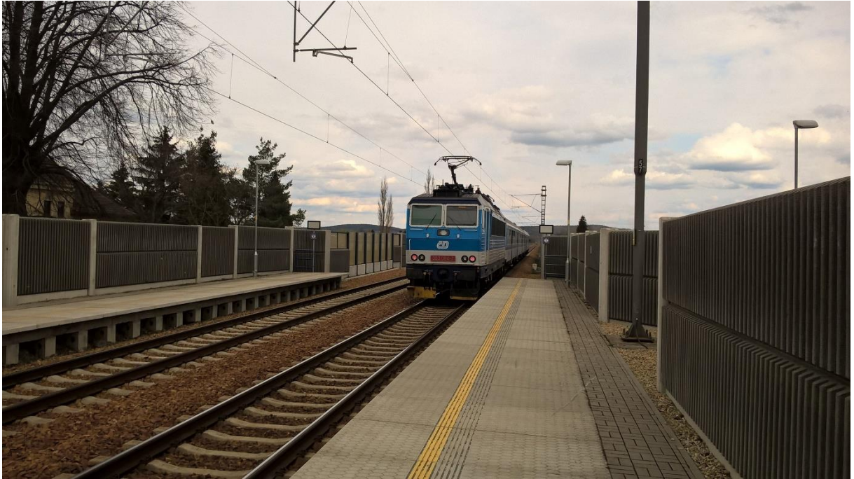
Obr. 17: Protihlukové stěny podél modernizované železniční trati [3]
