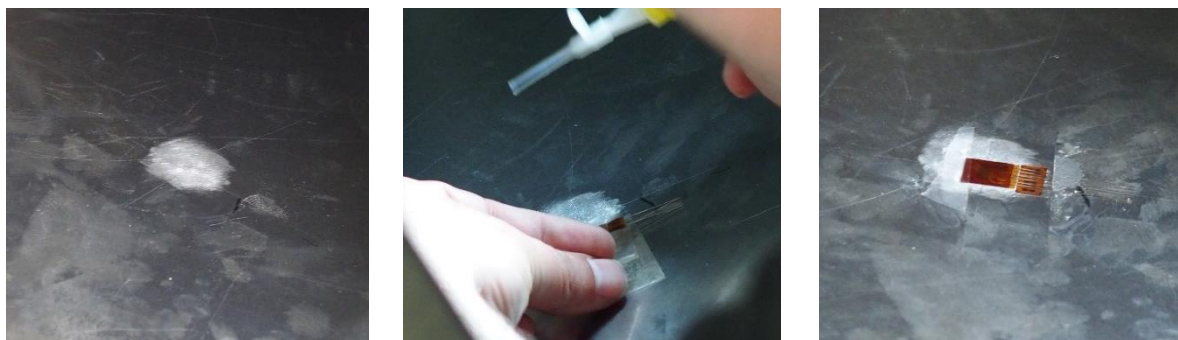
Obr. 5-8: Postup instalace tenzometru
