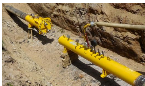
Obr. 5.2 Přivaření zaslepovacích den na volné konce po vyříznutí vzorku pro tlakovou zkoušku [39]
