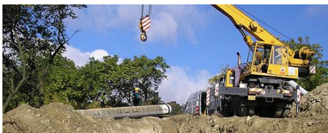
Obr. 5.1 Odběr vyříznutého vzorku pro tlakovou zkoušku [38]
