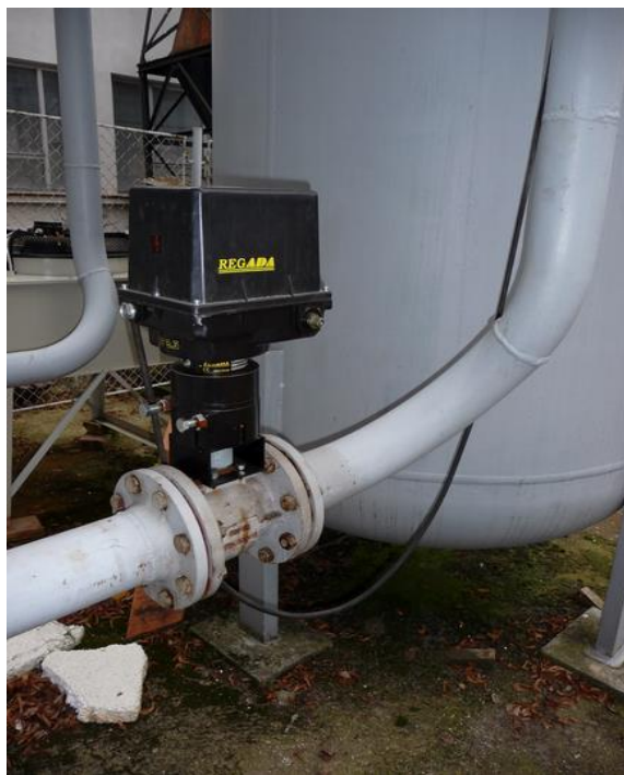
Obr. 2-3 Kulový ventil ovládaný servopohonem [L5]
