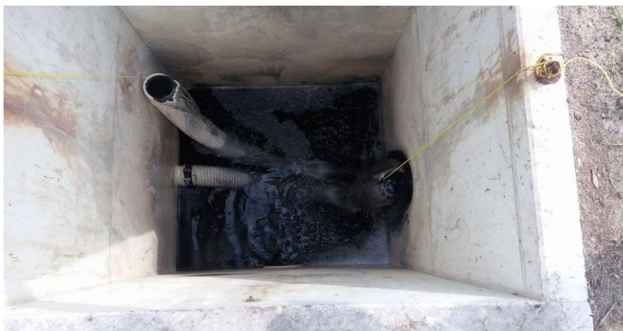
Obr. 7 KČOV ve Spáleném Poříčí – flexibilní hadice na regulaci hladiny ve filtračním loži
