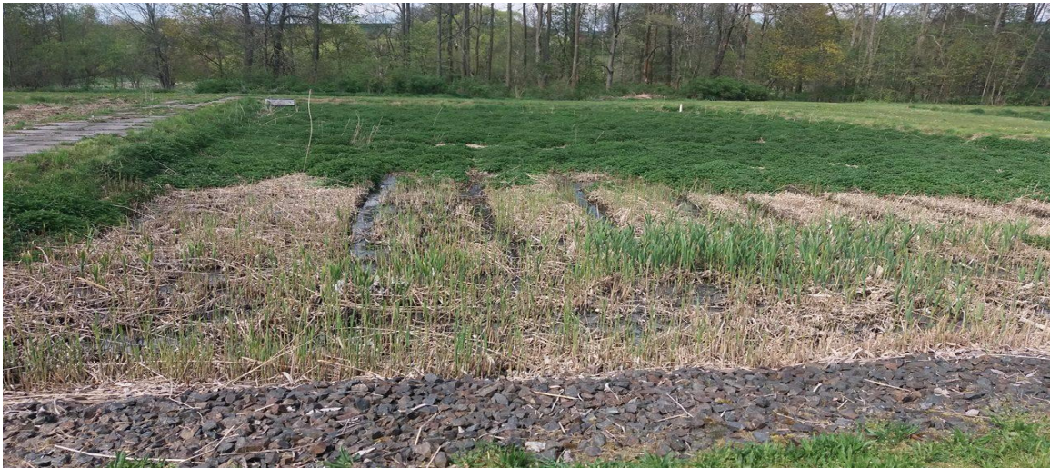
Obr. 8 KČOV ve Spáleném Poříčí-povrchový odtok
