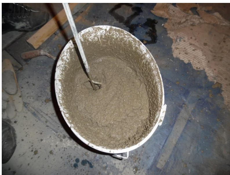
Obrázek 2.5 – Míchání betonové směsi, vlastní tvorba
