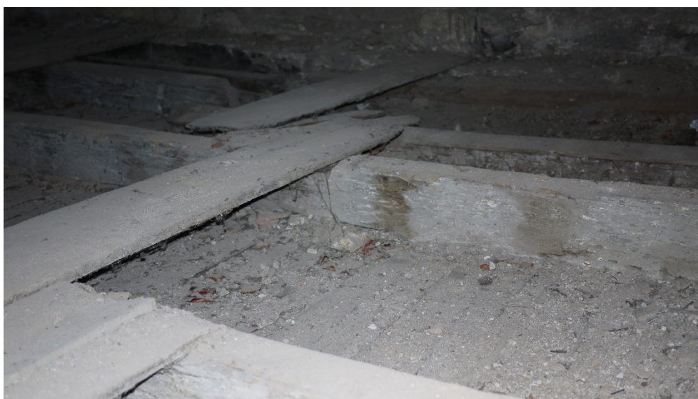
Obrázek 2.1.5 Pohled shora do konstrukce trámového stropu prostření místnosti západního křídla
