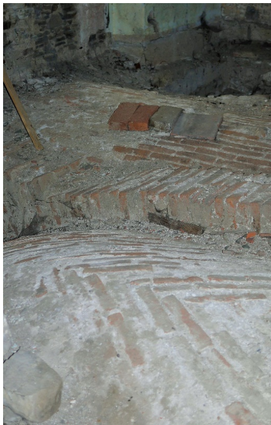
Obrázek 2.1.6 Pohled shora na klenby valené klenutých pasů – severní místnost západního křídla
