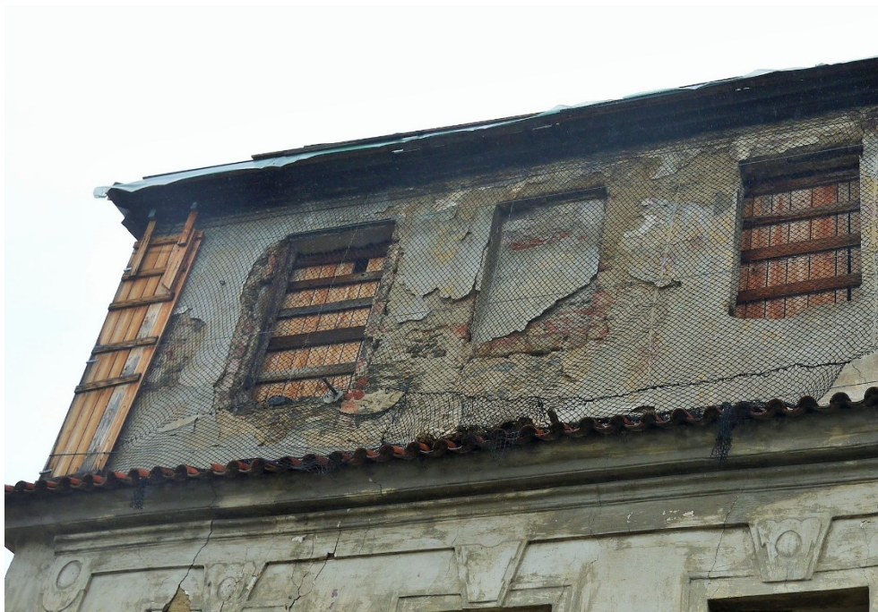
Obrázek 2.2.9 Jižní pohled na 3.NP věže
