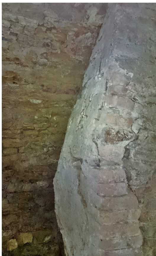
Obrázek 2.2.23 Boulení suterénní stěny
