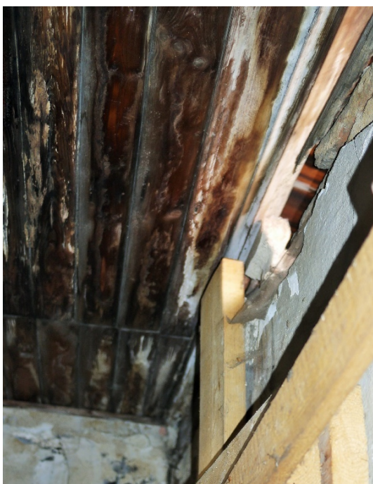
Obrázek 2.2.11 Pohled stropní konstrukce v 3.NP věže
