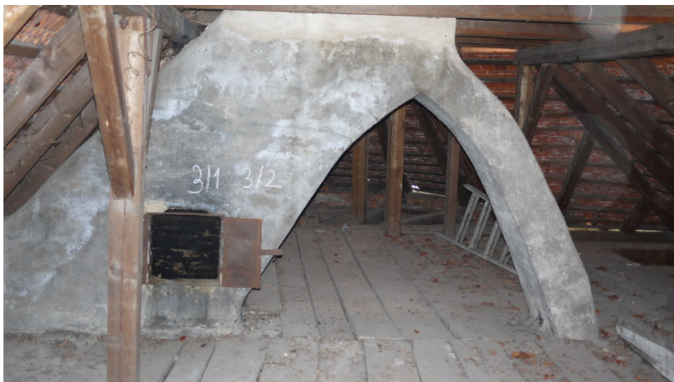
Obrázek 2.1.4 Východní komín s esovitým průběhem
