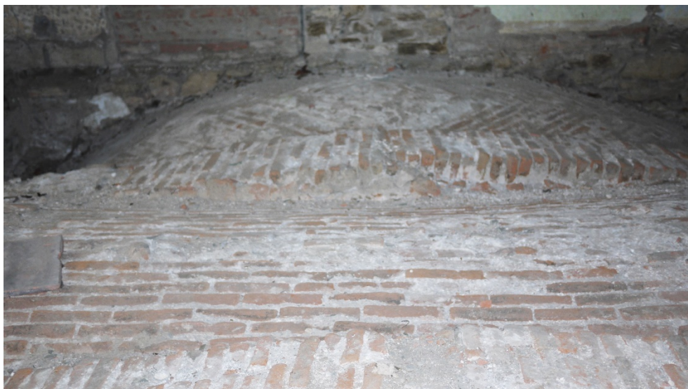
Obrázek 2.1.7 Pohled shora na klenby valené klenutých pasů – severní místnost západního křídla
