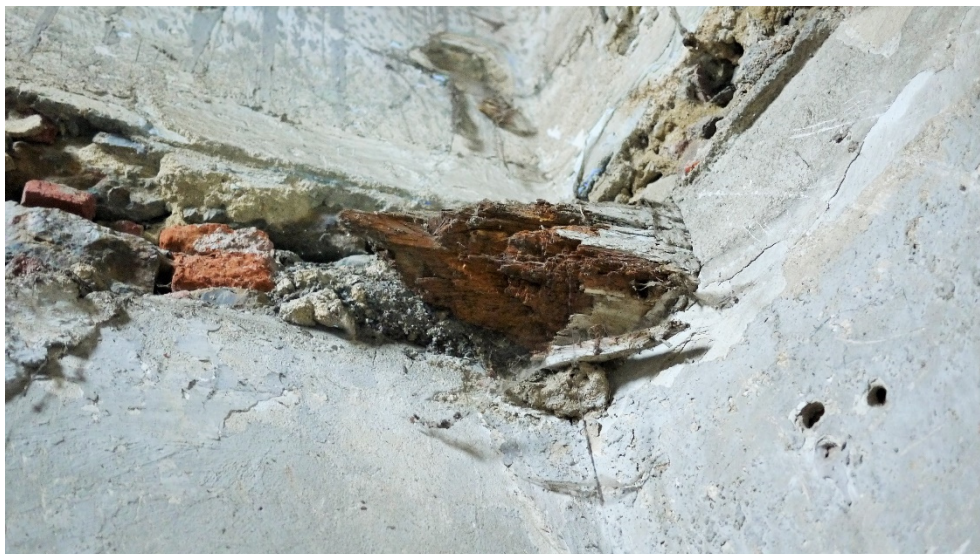
Obrázek 2.2.25 Zbytek trámu ve zdivu
