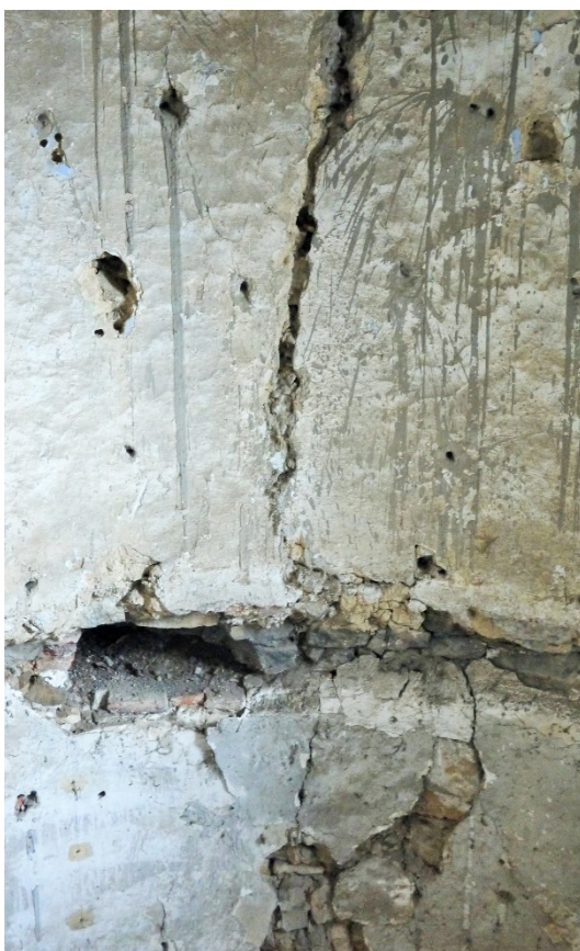
Obrázek 2.2.22 Trhlina ve válcovém přístavku
