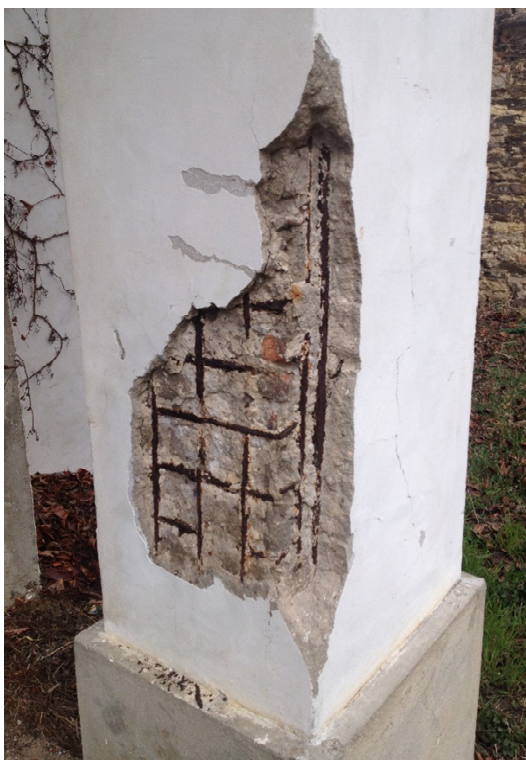
Obrázek 2.1.3 Sloup zesílen torkretovou omítkou s ocelovou výztuží
