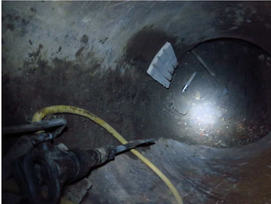
Obrázek 2.10- Ražení protlačováním s ručním rozpojováním zeminy na čelbě na stavbě Novomlýnská věž
