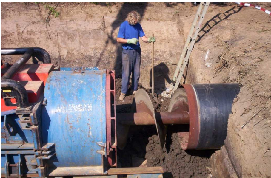
Obrázek 2.7- Čištění dokončeného protlaku- vytahování šnekových unašečů, vrtná souprava American Augers 60-120 Turbo [16]
