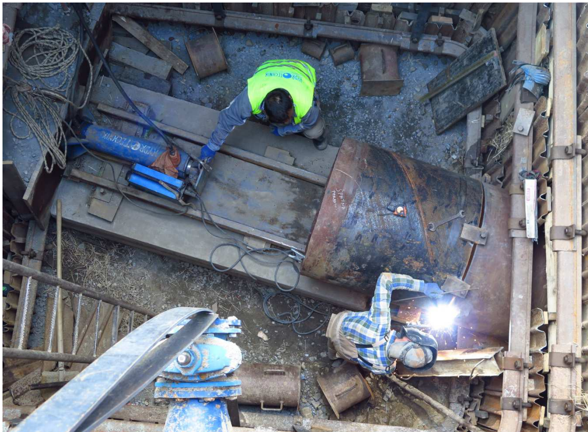
Obrázek 3.3 - Startovací šachta s hydraulickou tlačnou soupravou, navařování posledního kusu ocelové chráničky
