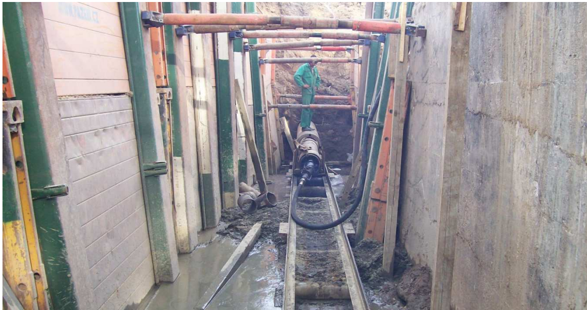
Obrázek 2.5- Vodorovné beranění s otevřeným čelem, Říčany 500 Evos (Grundoram Koloss) [16]
