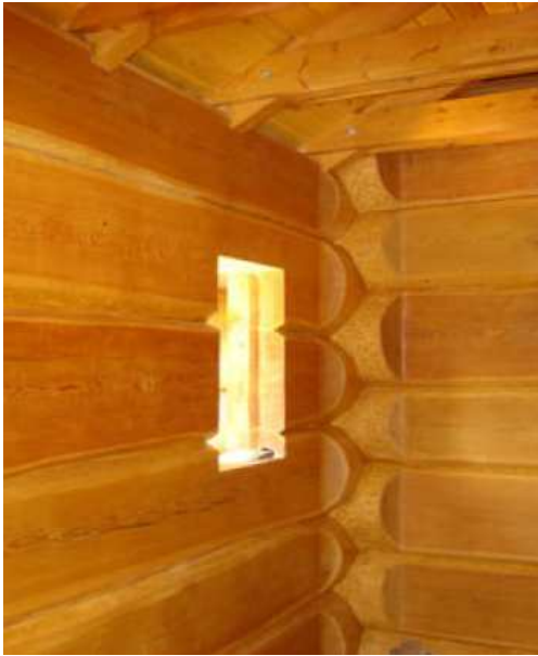
Obr. 5 Příklad výstavby srubu hákovou technologií
