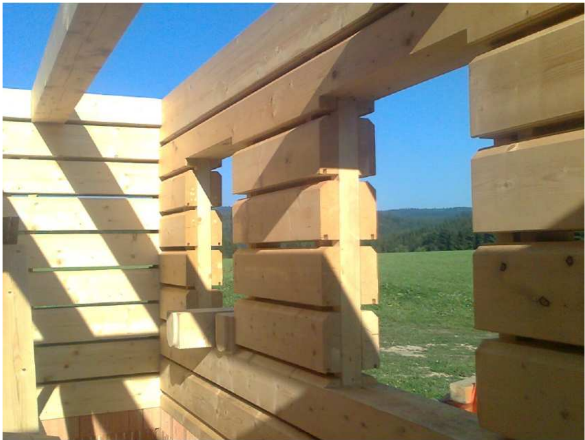
Obr. 7 Roubenka s mezerou mezi štětovnicemi. Foto DEKWOOD
