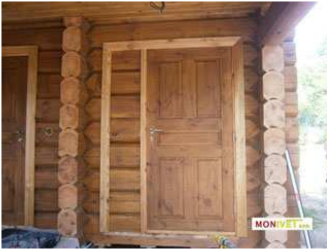
Obr. 4 Příklad výstavby srubu norskou technologií
