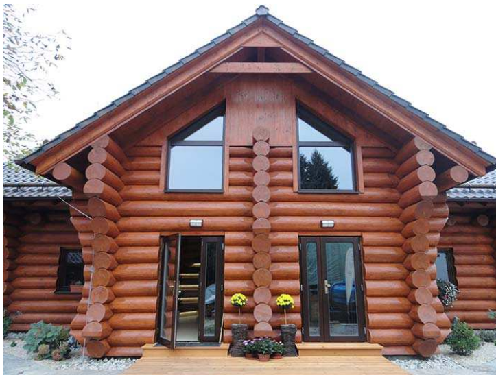
Obr. 2 Příklad výstavby srubu kanadskou technologií
