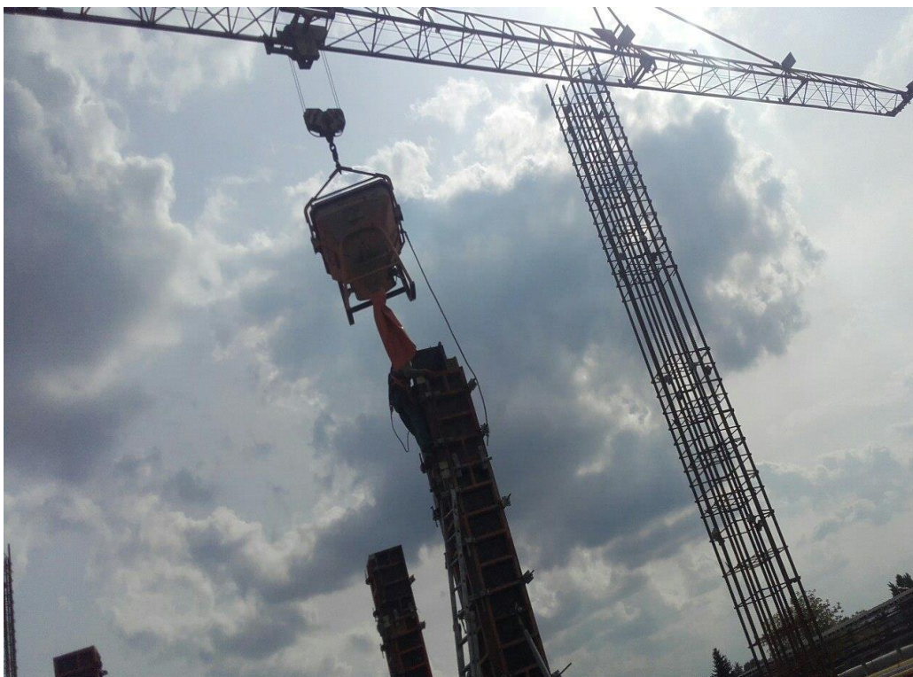
Obr. 19 Zahájení betonáže sloupů
