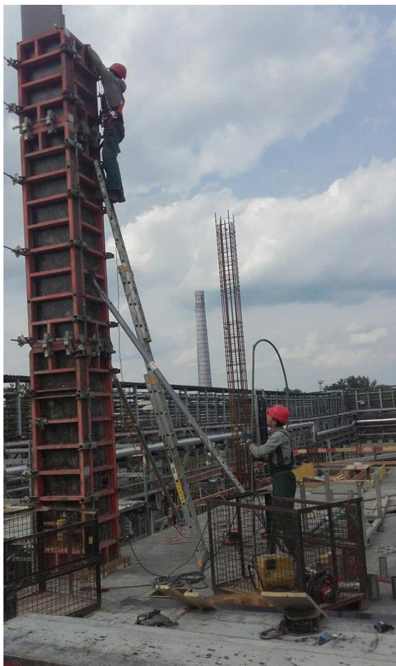
Obr. 17 Příprava před betonáží sloupů
