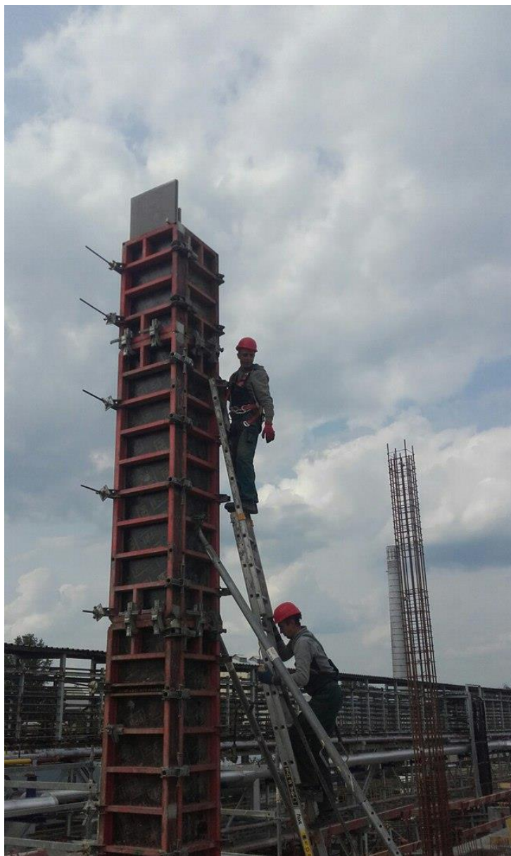
Obr. 18 Příprava před betonáží sloupů
