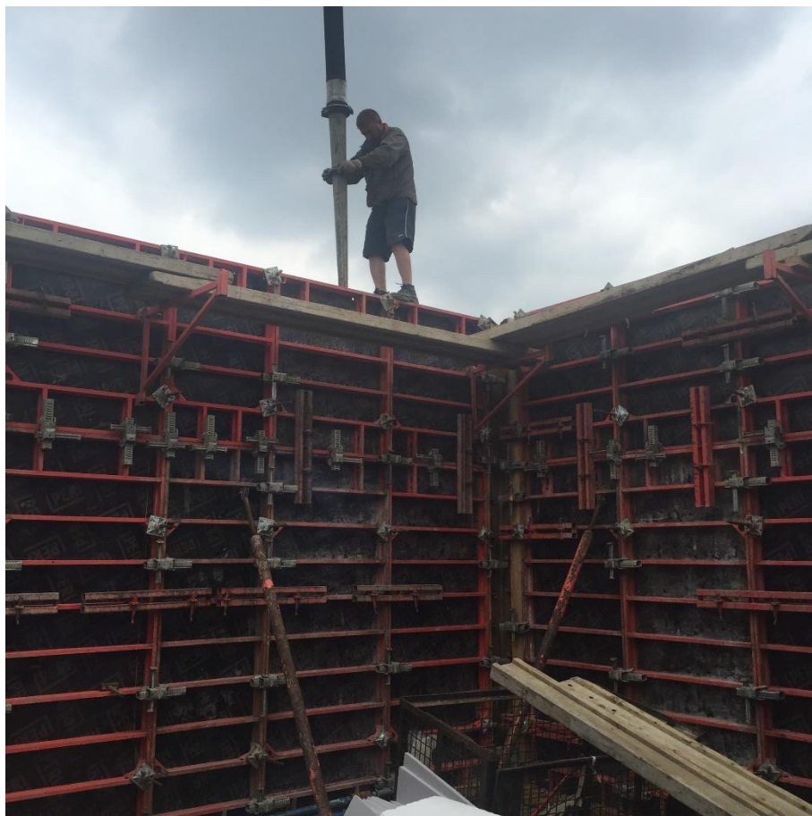
Obr. 22 Betonáž stěn
