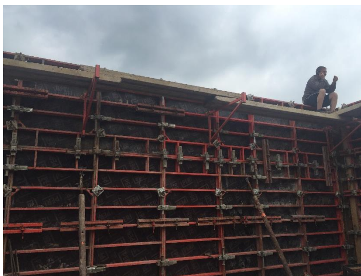
Obr. 21 Očekávání betonu na stavbě
