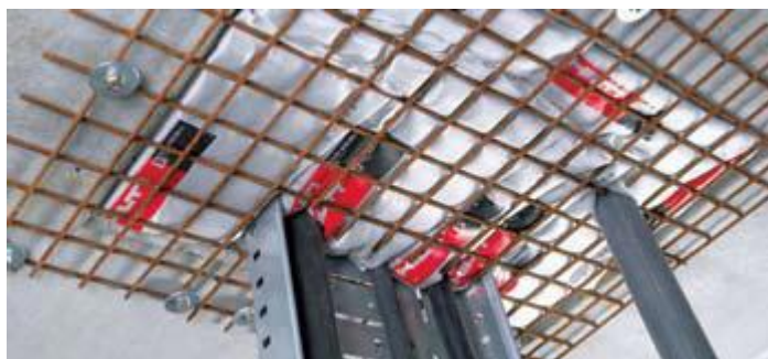
Obr. 62 Použití sáčků Hilti CP 651 ve stropní konstrukci
