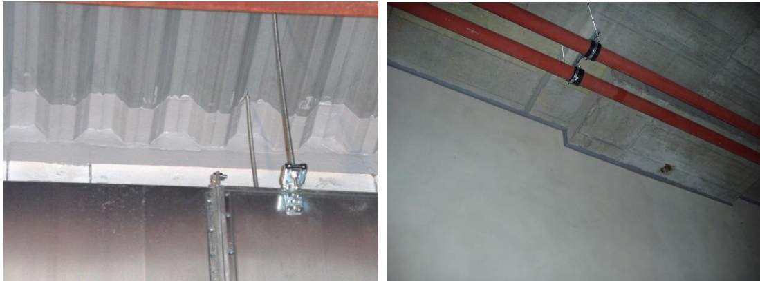
Obr. 67 Kombinace minerální vlny a protipožárního nátěru (vlevo), Těsnění spáry protipožárním tmelem (vpravo)
