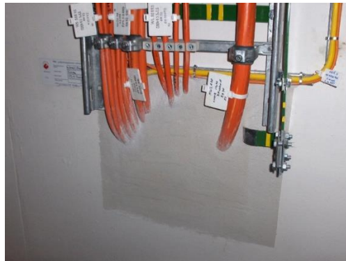
Obr. 50 Postup realizace měkké ucpávky: a) Prázdný otvor v konstrukci b) Umístění instalací c) Vyplnění otvoru minerální vlnou a tmelem kolem instalací d) Provedení povrchového protipožárního nátěru
