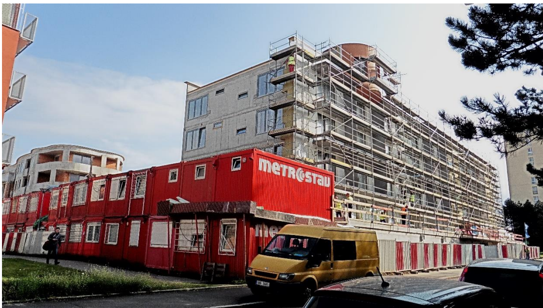
Obr. 62 Stavba CTR group a.s., bytového domu v Kobyliších
