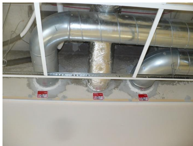
Obr. 48 Požární ucpávka prostupu vzduchovodu
