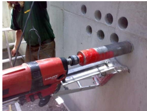
Obr. 25 Jádrové vrtání
