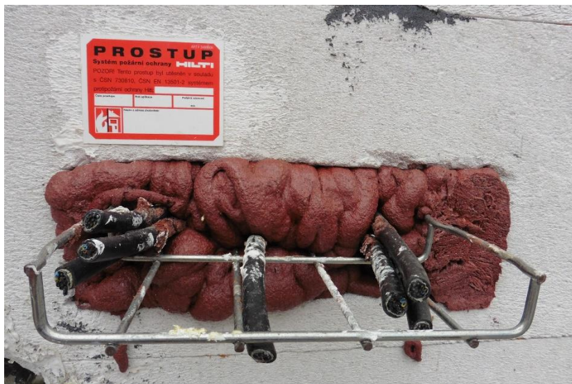
Obr. 55 Ucpání otvoru pěnou Hilti CFS-F FX (tréninková stěna firmy HILTI)
