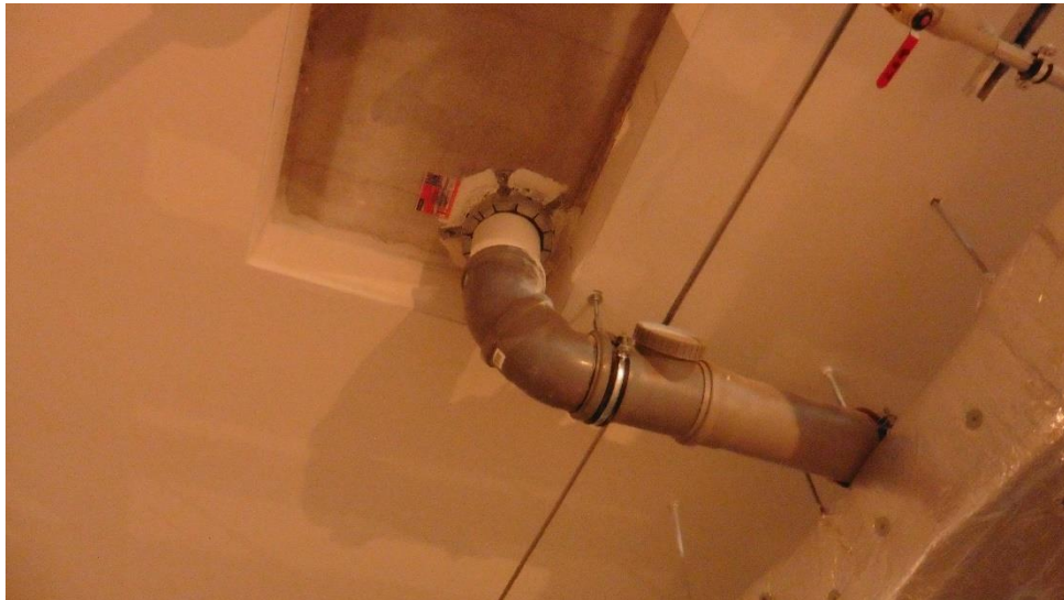
Obr. 63 Kobylisy – ucpávka řešena jako kombinace protipožárního nátěru a manžety
