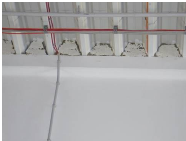
Obr. 50 Izolace je provedena z hořlavého materiálu EPS
