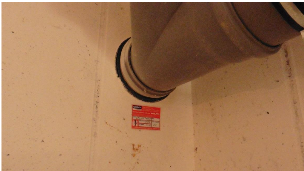
Obr. 64 Kobylisy – Ucpávka řešena vložením zpěňujících pásů do prostupu kolem potrubí
