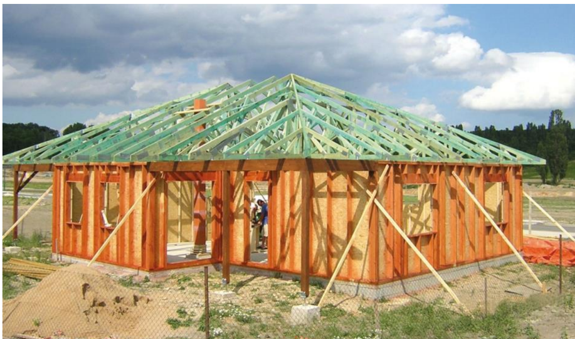
obr. 1 – probíhající hrubá stavba rámového systému (homebydleni.cz [online]. [cit. 13.5.2016].
