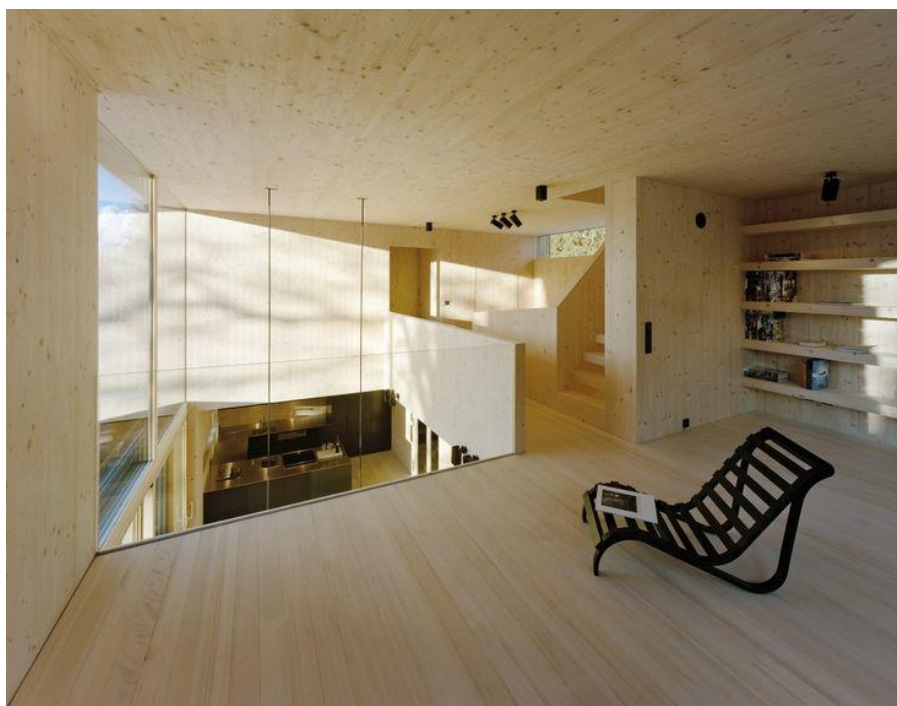
obr. 11 – Vzhled interiéru domu z CLT panelů ( https://s-media-cache-ak0.pinimg.com/ [online]. [cit. 14.5.2016]. Dostupný na WWW: https://s-media-cache-ak0.pinimg.com/736x/44/80/d8/4480d86fa96f4fb78373c194a7f09e94.jpg )
