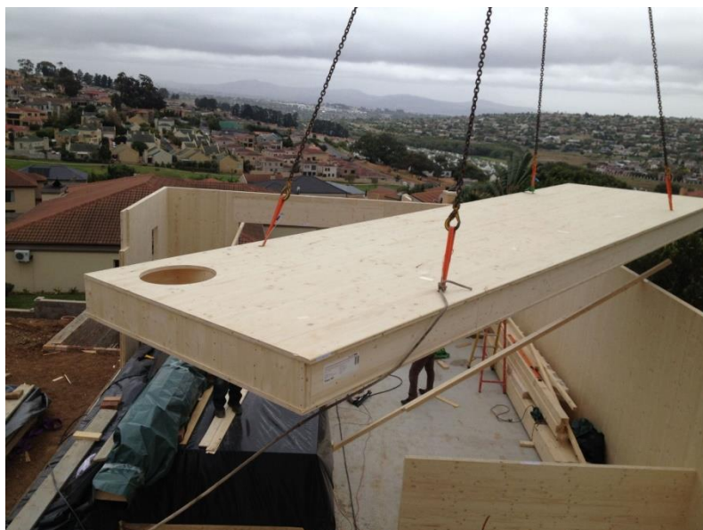
obr. 8 – Pohled na konstrukci panelu NOVATOP ELEMENT (AGROP NOVA [pdf]. NOVATOP ELEMENT Technická dokumentace. 2016. [14.5.2016]. http://www.novatop-system.cz/ke-stazeni/soubory-ke-stazeni/ )
