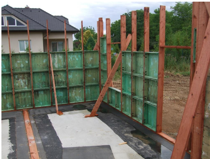
obr. 14 – Výstavba systému OVELOS (autor fotky: Jakub Vrba)
