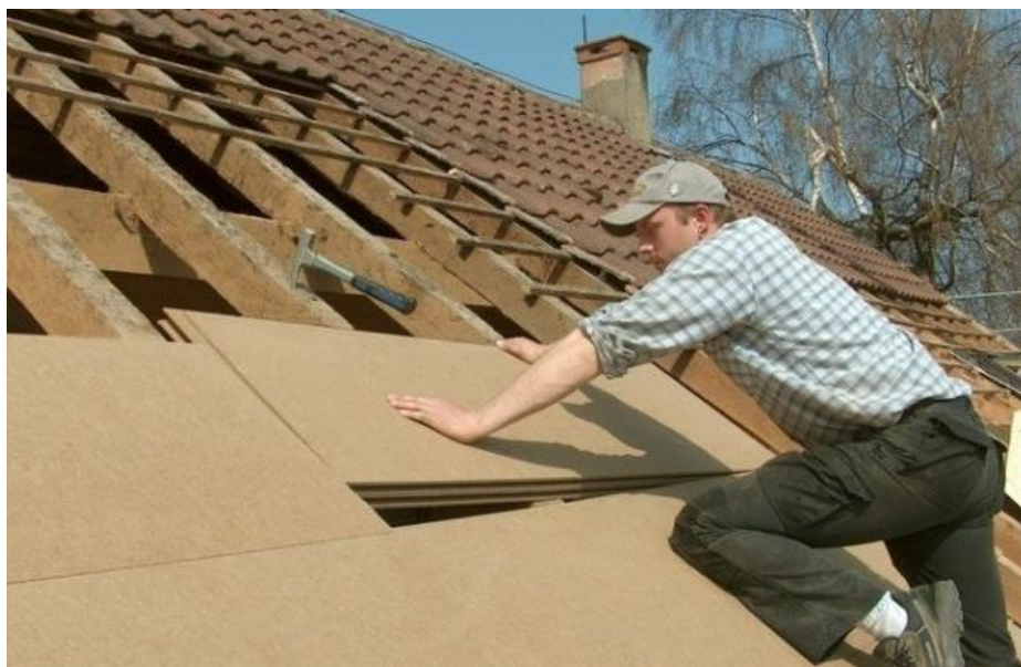
obr. 6 – Příklad aplikace dodatečné izolace STEICOspecial při rekonstrukci střechy ( http://www.videstehnika.lv/ [online]. [cit. 14.5.2016]. Dostupný na WWW: http://www.videstehnika.lv/img/items/15/special.jpg )
