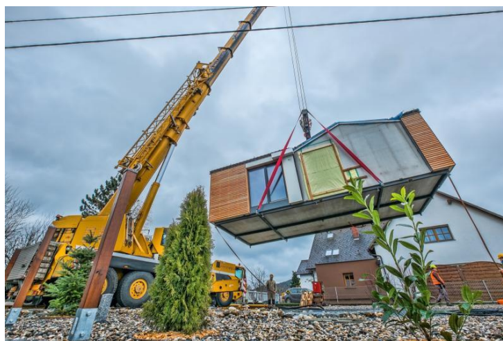
obr. 17 – Přeprava modulární dřevostavby WOODCON ( http://www.wood-con.cz/ [online]. [cit. 14.5.2016]. Dostupný na WWW: http://www.wood-con.cz/data/obsah_skryvany/7/20130423-140542.jpg )
