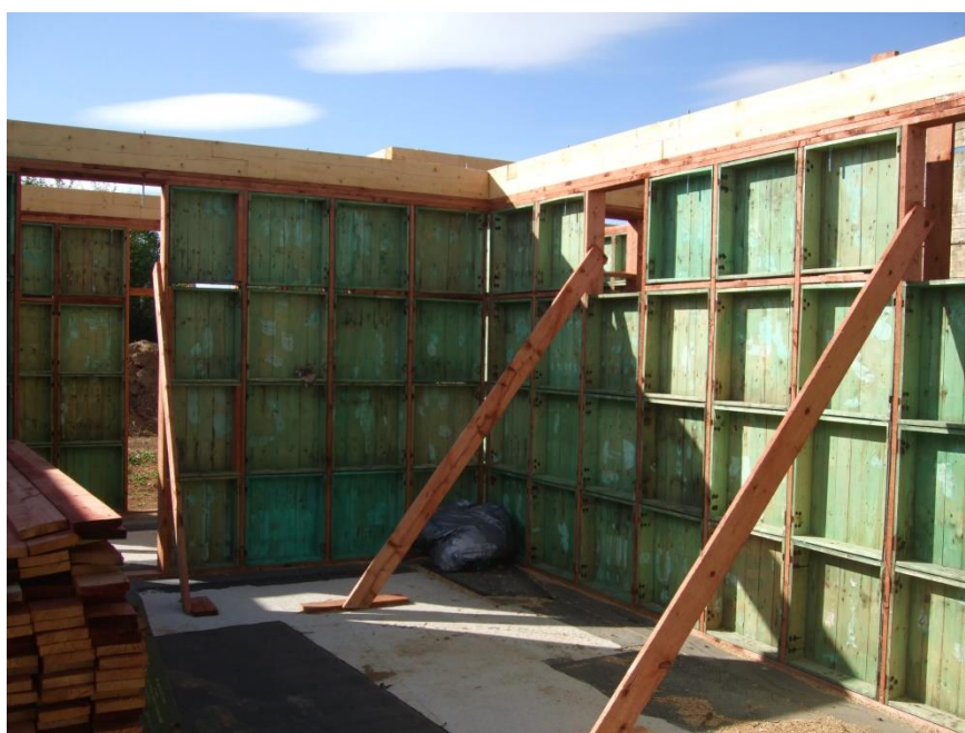
obr. 15 – Hotov svíslé nosné stěny systému OVELOS (autor fotky: Jakub Vrba)
