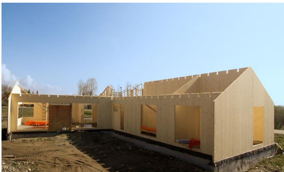
obr. 13 – Hrubá stavba přízemního rodinného domu zhotovená z CLT panelů ( http://www.kontraktning.sk/ [online]. [cit. 14.5.2016]. Dostupný na WWW: http://www.kontraktning.sk/files/galleries/fotky/batizovce-rd/drevostavba-z-clt-panelov-v-batizovciach-0280.jpg )
