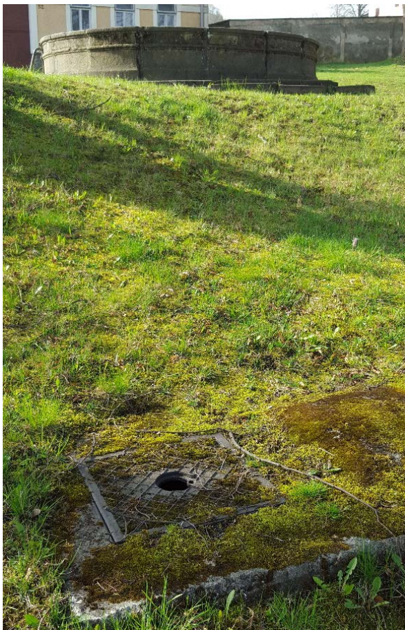
Obrázek 13 - Odpadní šachta pro výtok z kašny
