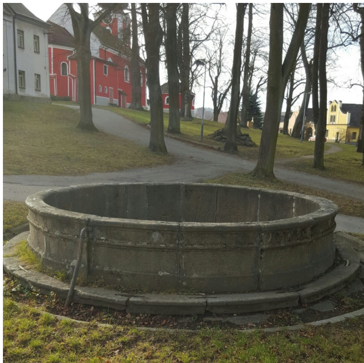
Obrázek 9 - Pohled na současný stav kašny a část náměstí
