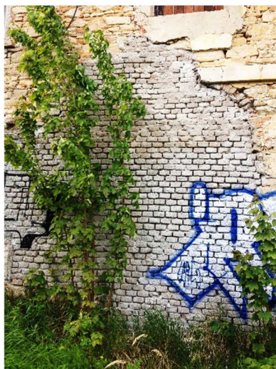
Obr. 2.16 Zazděný vstup - jihovýchodní průčelí
