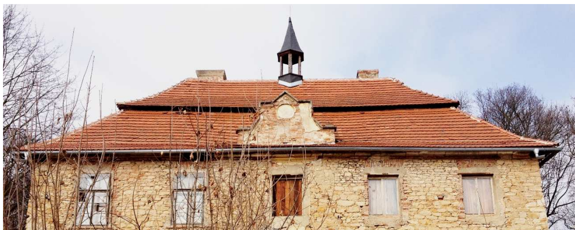
Obr. 2.10 Současný stav zastřešení
