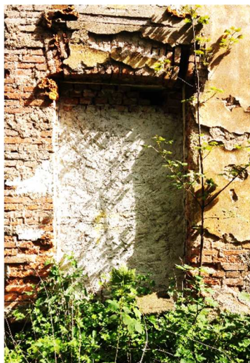
Obr. 2.17 Zazděný vstup - severozápadní průčelí
