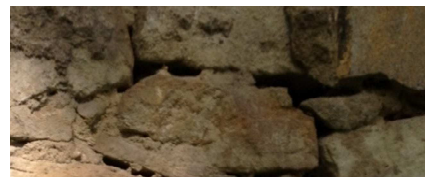
3.14, 3.15 Vyplavený spojovací materiál ze zdiva
