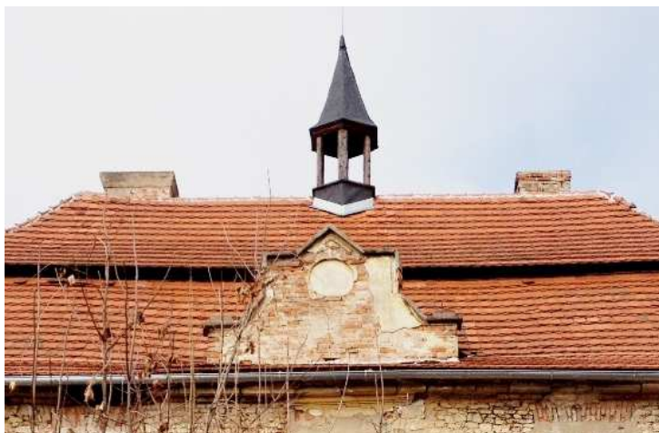
2.25 Střešní štítek s věžičkou
