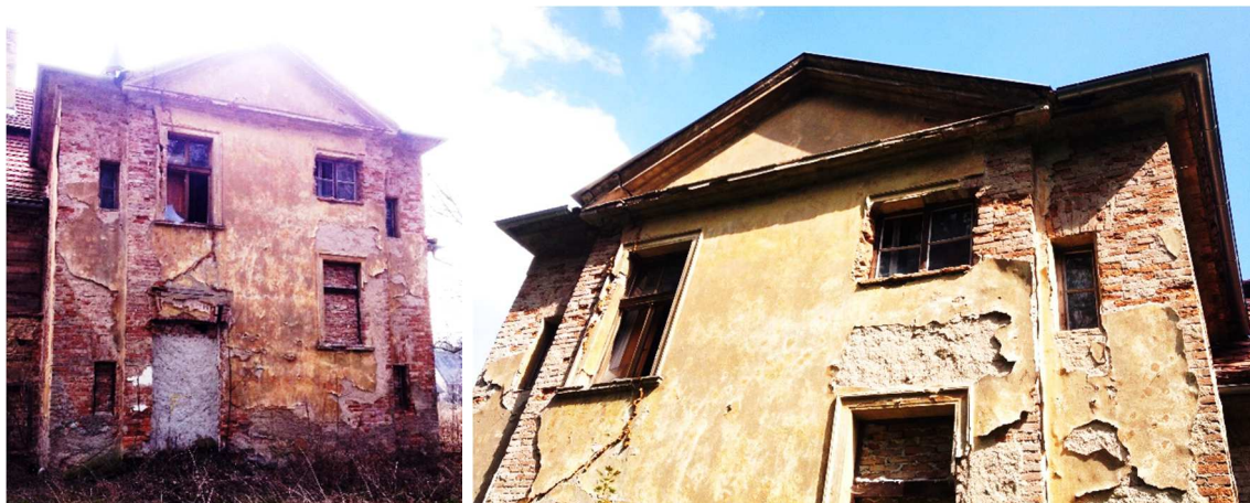
Obr. 2.14. 2.15 Rozmanité druhy oken na severozápadní přístavbě
