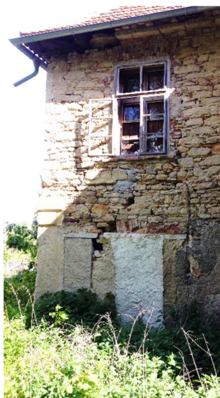
3.26, 3.27 Trhlina na severozápadním průčelí
