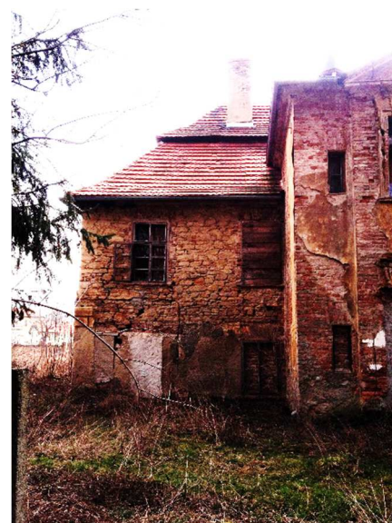
3.33 Napojení přístavby a původní stavby
