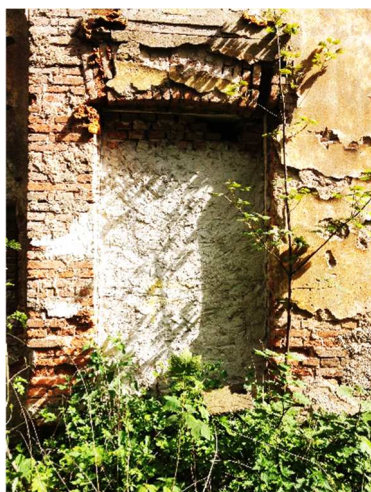
3.48 Zazděný vstup do objektu
