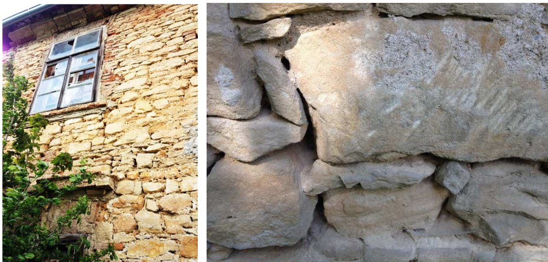
Obr. 2.3, 2.4 Kamenné zdivo na původní části objektu.
