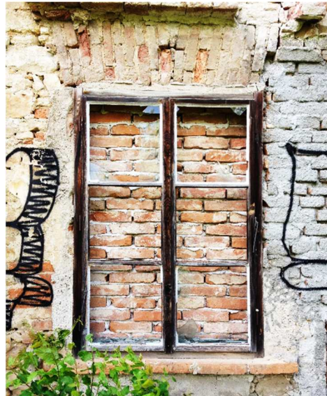
Obr. 2.8 Cihelný překlád nad okenním otvorem
