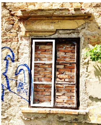
2.24 Okno s pozůstatky šambrán a říms
