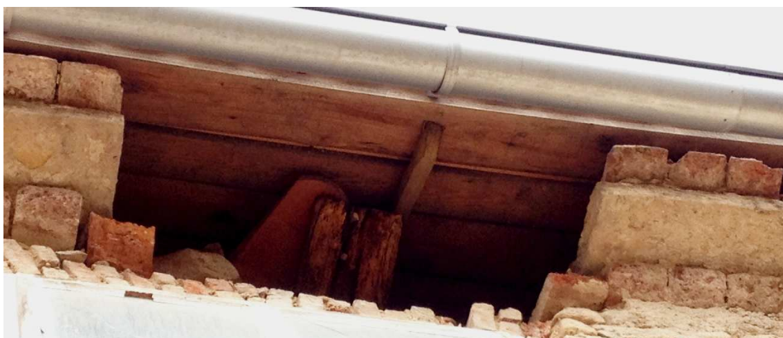
Obr. 2.9 Detail krokve a okapové římsy
