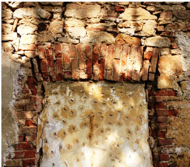
Obr. 2.7 Cihelný překlád nad dveřním otvorem
