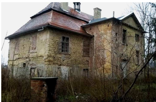
Obr. 1.9 Současný stav zámku – severozápadní průčelí
