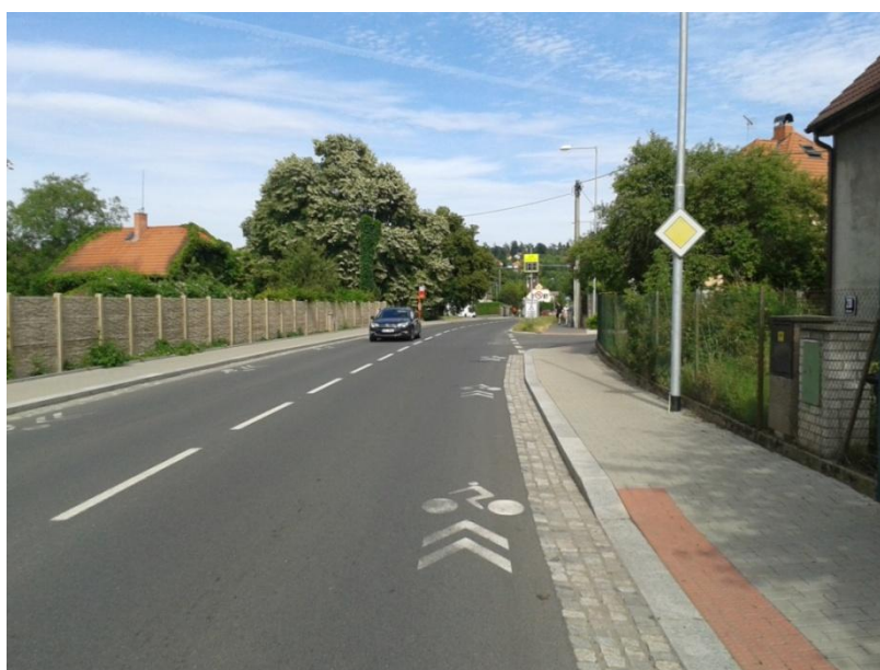
Obrázek 7 - Ulice Rýdlova po nedávné rekonstrukci (vlastní foto)
