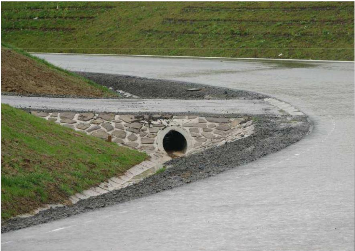
obrázek číslo 1. – betonový propustek
