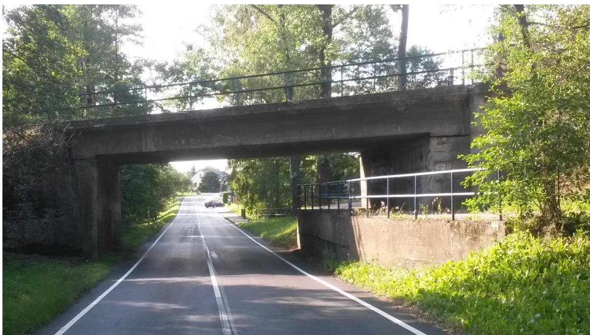
Obrázek 16: Pohled na viadukt [foto autora]
