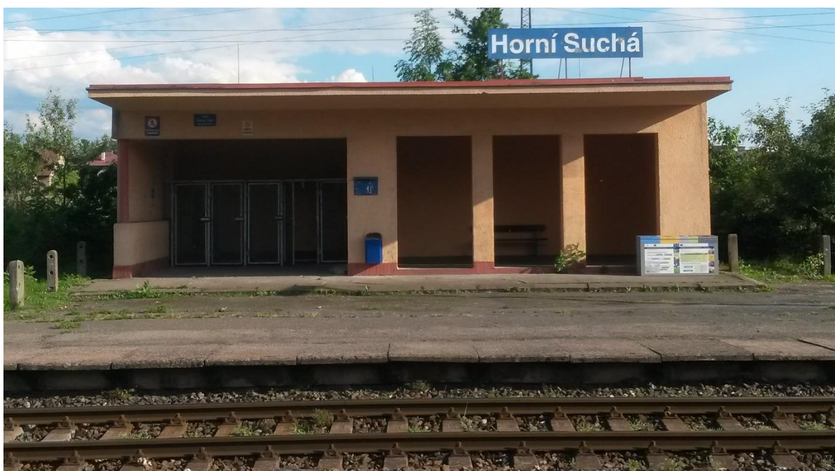
Obrázek 15: Stávající přístřešek ve směru Český Těšín [foto autora]
