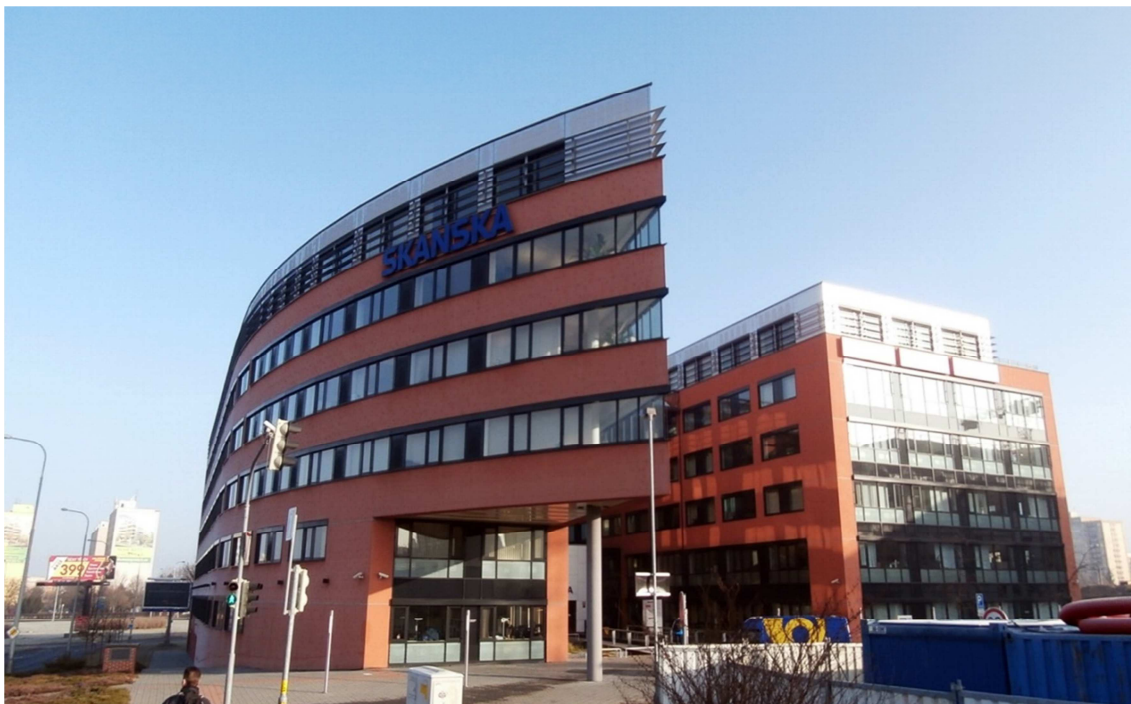
Obr. 7.1 - Administrativní budova Opatov
