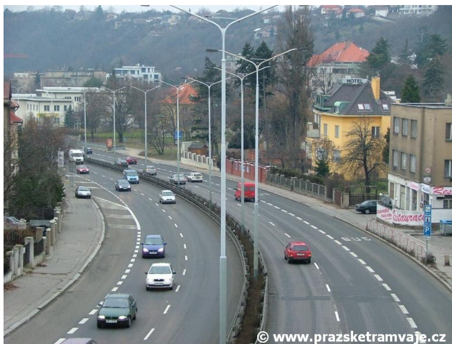
Obrázek 2 Současný stav podoby komunikace V Holešovičkách, zdroj prazsketramvaje.cz 2
