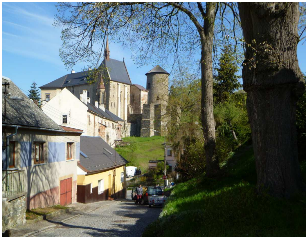
Obr. 9b: Jižní pohled na hrad z ulice Zahradní - současnost [zdroj: autor]
