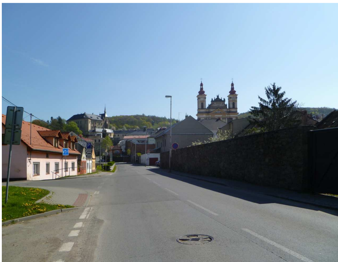
Obr. 8b: Dvorská ulice – současnost [zdroj: autor]
