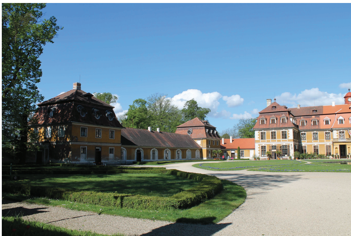
Obr. 2b: Rájec_2016_Levé křídlo zámku_autor
