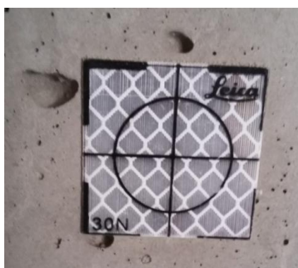
Obr. 3.7: Stabilizace pozorovaného bodu
