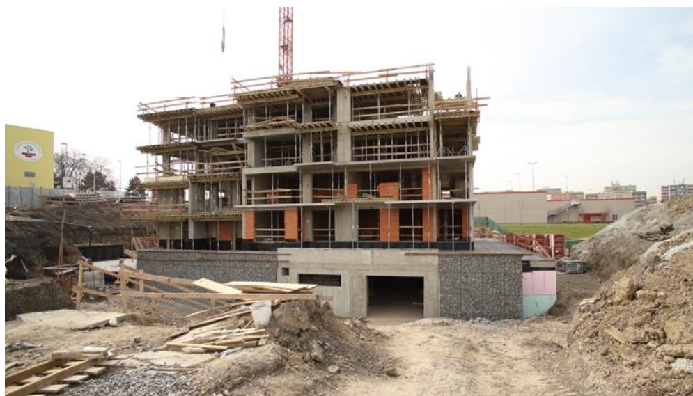
Obr. 3.2: Celkový pohled při výstavbě (fotografie převzata z [5])
