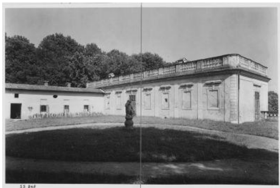
Obr 28: Terasa před zahradním průčelím zámku 1951 [zdroj NPU]
