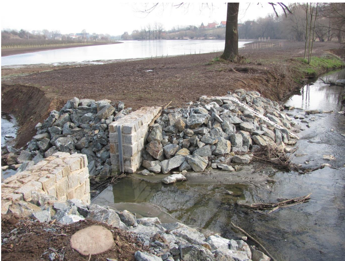
Fotografie 12 Nátokový objekt MVN Víťov (autor: Jakub Stašek)
