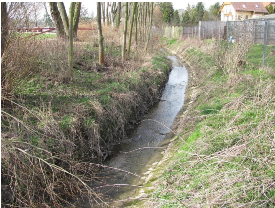
Fotografie 2 Opevněné koryto Červeného potoka (autor: Jakub Stašek)
