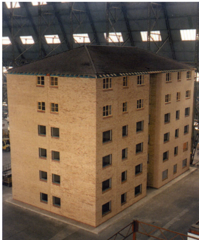
Obr. 10 Šestipodlažní budova z lehkého dřevěného skeletu
