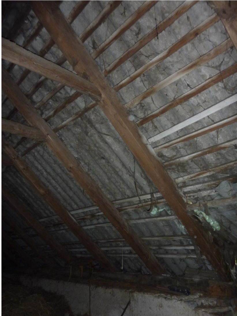
Obr. 7 Původní objekt – stávající krov
