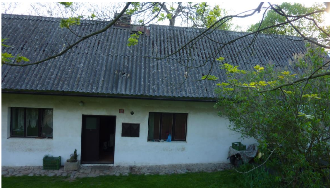
Obr. 5 Původní objekt z příjezdové komunikace- severovýchod
