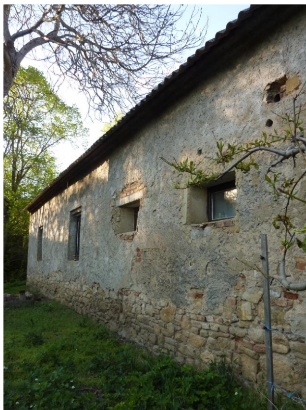
Obr. 6 Původní objekt - jihozápad
