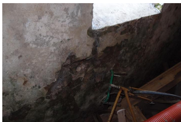
foto 54 - Pohled na vnitřní parapet okna v jihozápadní suterénní stěně
