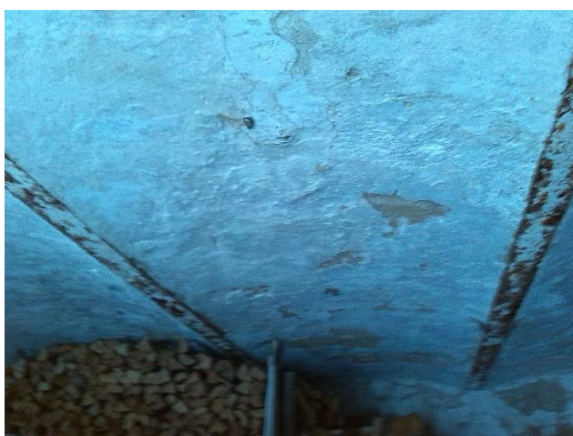
foto 70- Plochá zděná klenba do ocelových I profilů nad prostorem chlívku (místnost 1.13)
