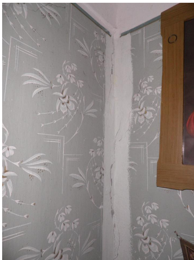
foto 82 – Trhlina na styku příčky a vnitřní nosné stěny (foceno z místnosti 2.07)
