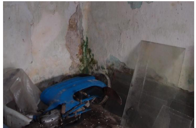
foto 39 – Severní roh místnosti 1.08
