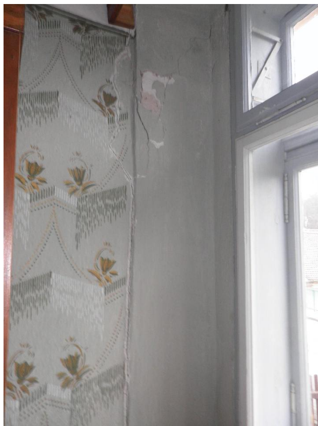
foto 82 – Trhlina na styku příčky a vnitřní nosné stěny (foceno z místnosti 2.07)
