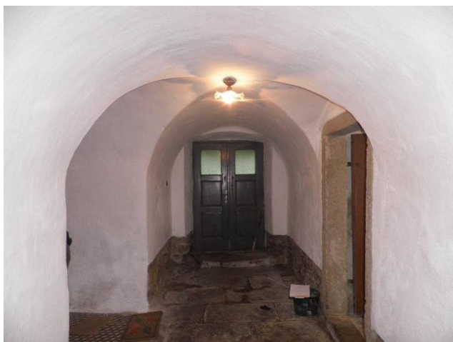
foto 15 - Pohled na vchod do objektu v jihozápadní obvodové stěně
