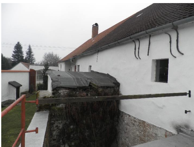
foto 12 – Pohled na severovýchodní stěnu objektu od severu (foceno ze střechy nad turbínou- místnost 1.12)
