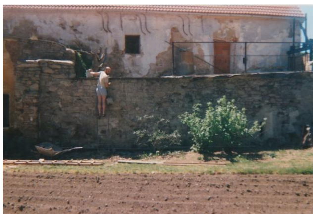
foto 4 – Pohled od severovýchodu na mlýnici (rok 1998)
