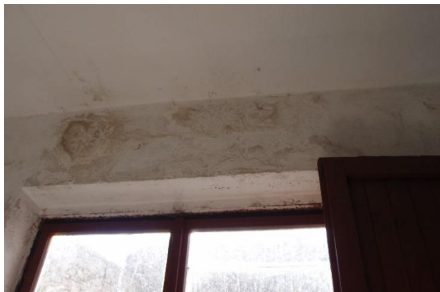
foto 67- Pohled na nadpraží okenního otvoru
