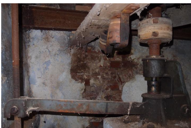
foto 58 - Pohled na severovýchodní suterénní stěnu
