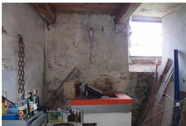
foto 52 - Pohled na jihozápadní suterénní stěnu
