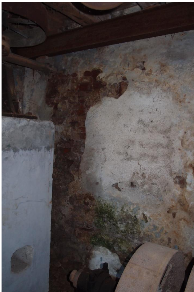
foto 59 - Pohled na severovýchodní suterénní stěnu
