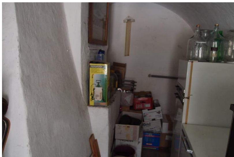
foto 80 – Pohled na místnost 2.05 směrem ke kuchyni (místnost 2.04)
