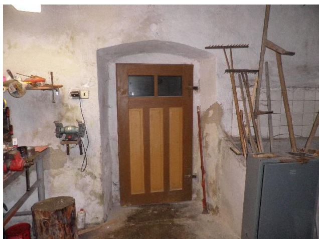
foto 41 – Pohled na vstup z chodby (místnost 1.01) do prostoru dílny (místnost 1.09)
