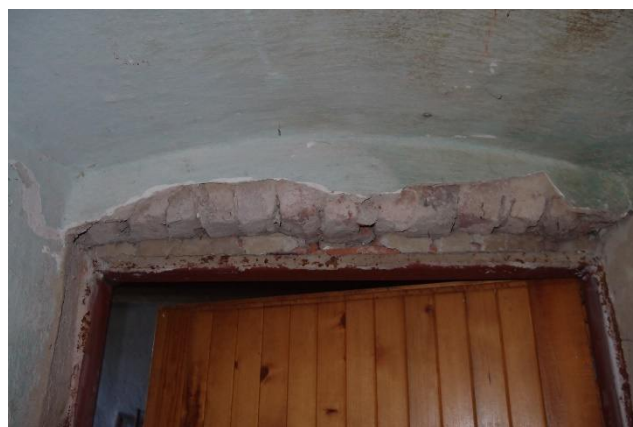
foto 44 – Pohled na nadpraží spojovacích dveří mezi prostorem dílny (místnost 1.09) a prostorem mlýnice (místnost 1.10), foceno z místnosti 1.09
