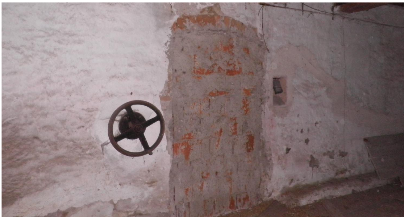
foto 103 - Zazděný výstup nad prostor turbíny (Místnost 1.12)
