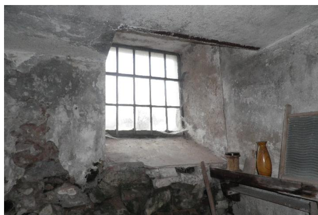
foto 64 - Okno v jihozápadní suterénní stěně
