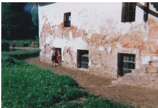
foto 3 – Pohled od jihozápadu na mlýnici (rok 1998)
