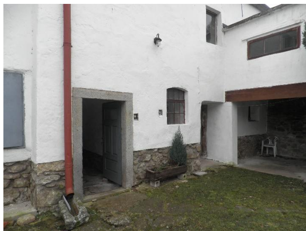
foto 14 – Pohled od severovýchodu na vstup do objektu ze zahrady
