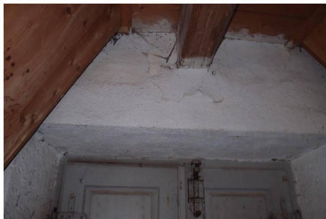
foto 94- Stopa vlhkosti nade dveřmi v místě uložení stropního průvlaku (jihozápadní stěna)
