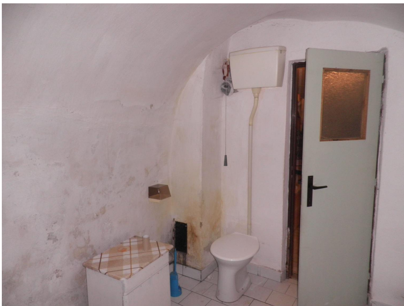
foto 25 – Pohled na dělicí příčku mezi místností 1.04 a 1.05
