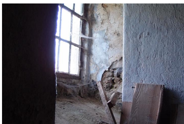
foto 49 - Detail ostění okna v jihozápadní suterénní stěně mezi prostorem mlýnice (místnost 1.10) a muzeem (místnost 1.11), foceno z místnosti 1.10
