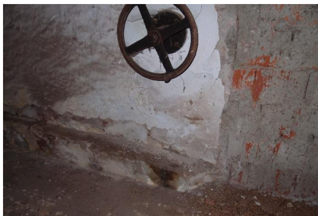
foto 86- Styk svislé nosné stěny 2.NP a svislé nosné stěny 1.NP
