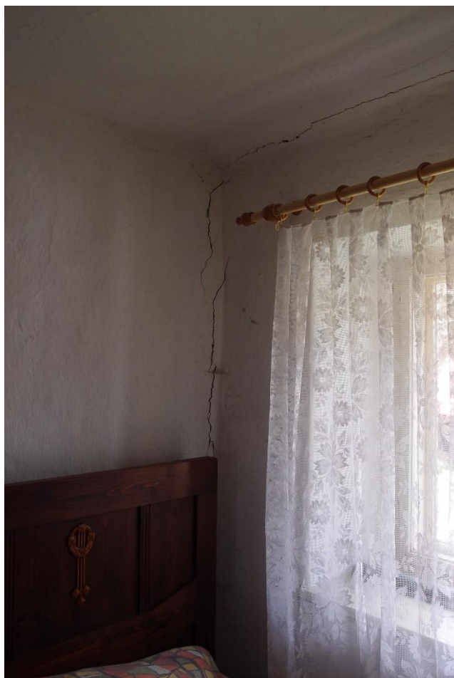
foto 72 – Severní roh ložnice (místnost 2.02) pozn.: Ve stavebně technické dokumentaci s označením TR 9
