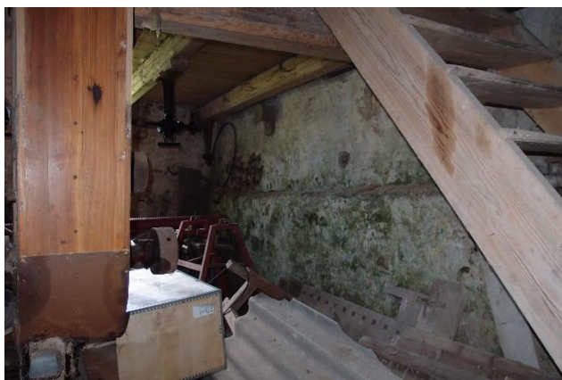
foto 61 - Pohled na severozápadní suterénní stěnu
