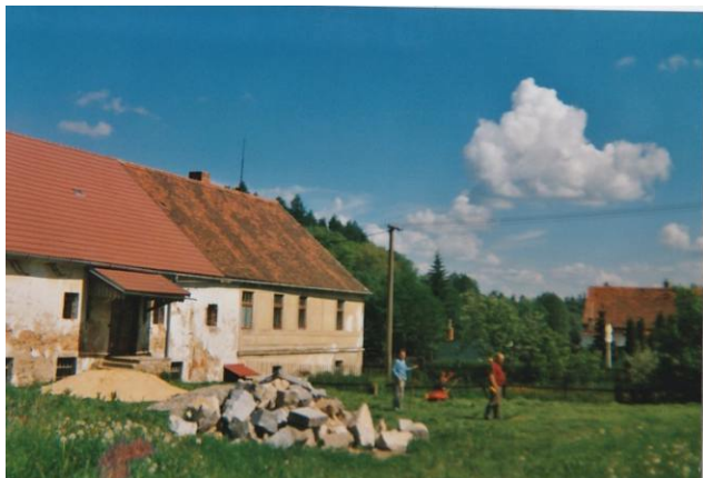
foto 1 – Pohled od jihozápadu na obytnou část (rok 1998)
