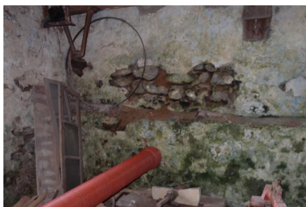
foto 56 - Pohled na severozápadní suterénní stěnu
