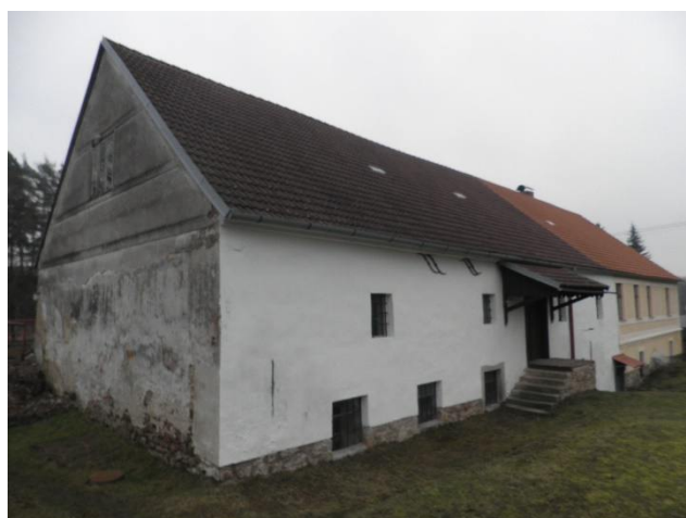
foto 10 – Pohled od západu na mlýnici
