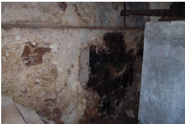
foto 57 - Severozápadní suterénní stěna- před schodištěm
