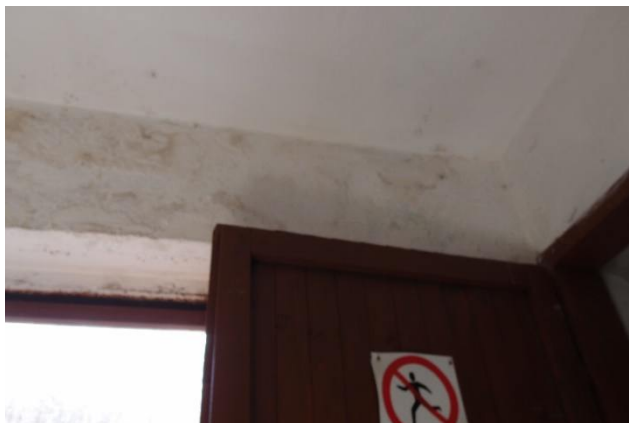
foto 68- Pohled na nadpraží okenního otvoru
