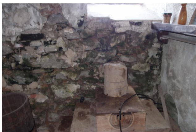
foto 65 - Parapet okna v jihozápadní suterénní stěně
