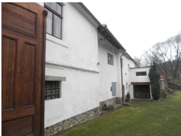
foto 13 – Pohled na severovýchodní stěnu objektu od východu
