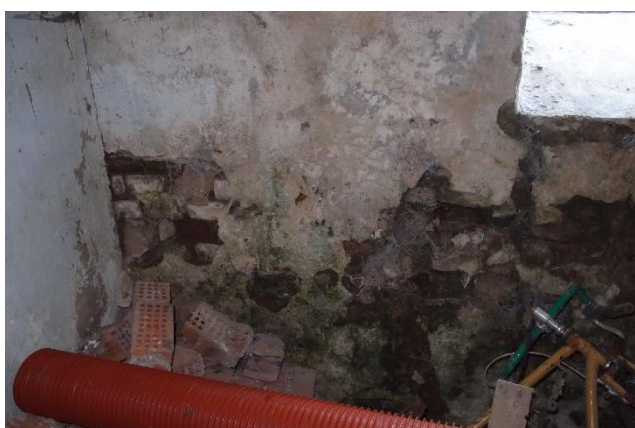
foto 53 - Pohled na jihozápadní suterénní stěnu
