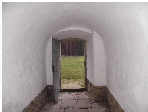
foto 16 - Pohled na vchod do objektu v severovýchodní obvodové stěně
