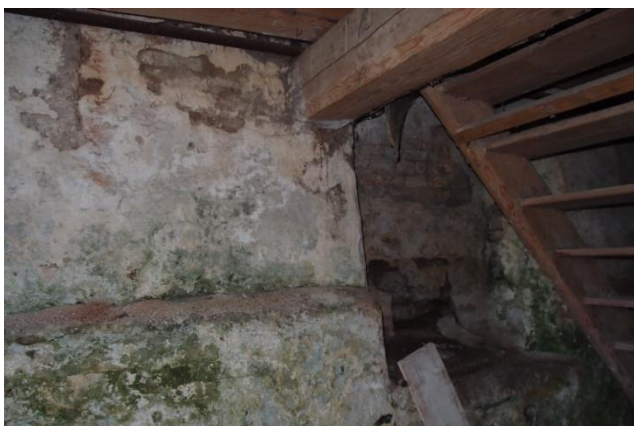
foto 60 - Výklenek v severozápadní suterénní stěně
