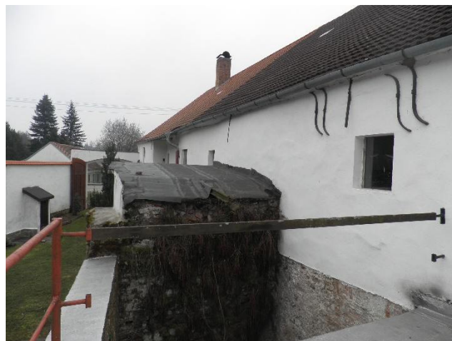
obr. 13 – Pohled od severu na SV fasádu objektu na SV stěně je vidět ukotvení trámových kleštin
