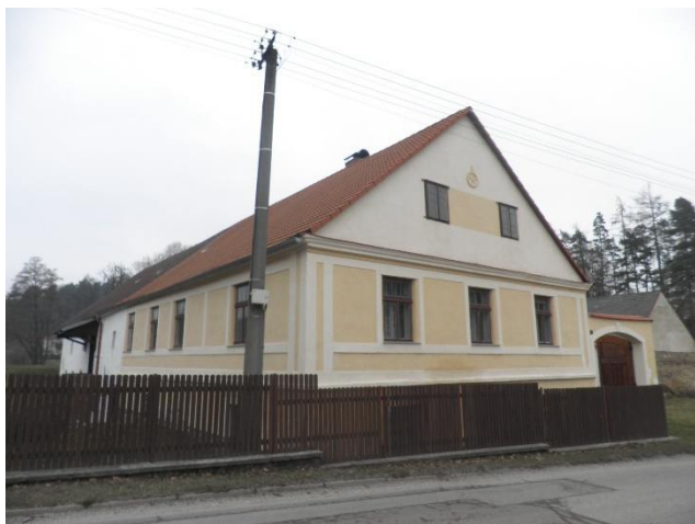
obr. 6 – Pohled na fasádu objektu od jihu
