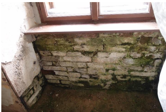
obr. 22 – Parapet okna v místnosti 1.07 v jihozápadní stěně, viz též foto 33
