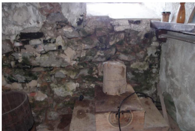
obr. 14 – Parapet okna v jihozápadní stěně místnosti 1.11 (viz též foto 65)
