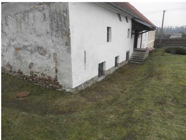
obr. 12 – Pohled od západu na roh objektu na JZ stěně je vidět ukotvení trámových kleštin
