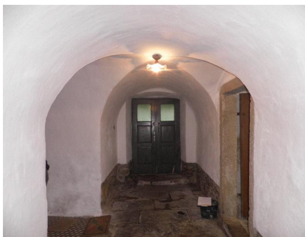
obr. 17 - Křížová klenba nad prostorem domovní chodby (místnost 1.01) vzniklá průnikem dvou valených kleneb (viz též foto 15)
