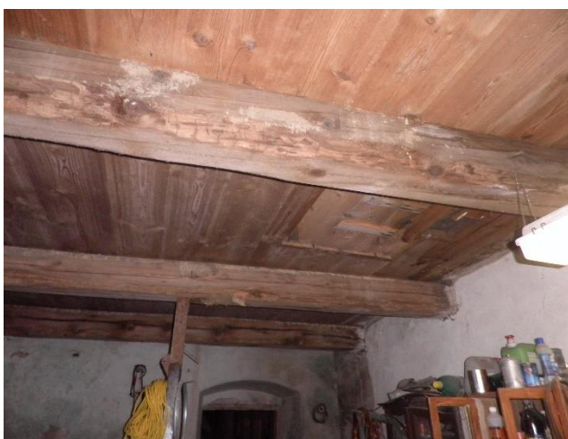
obr. 16 – Pohled na jednoduchý trámový strop nad prostorem dílny (místnost 1.09)
