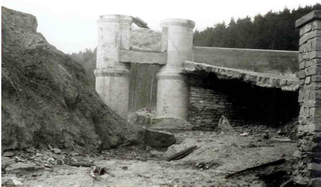
Obrázek 2 – Dobová fotografie protržené hráze MVN Mladoňovice – pohled proti vodě.
