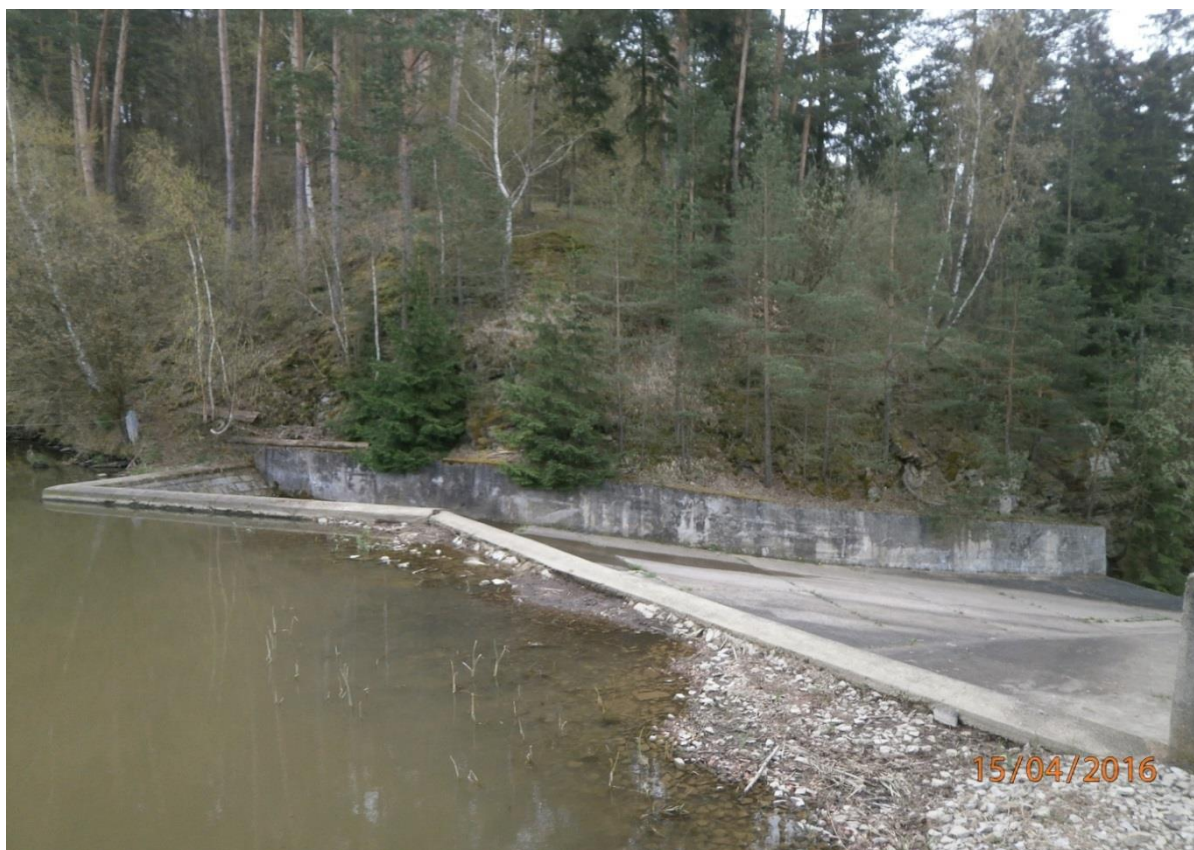
Obrázek 10 – Přelivná hrana bezpečnostního přelivu.
