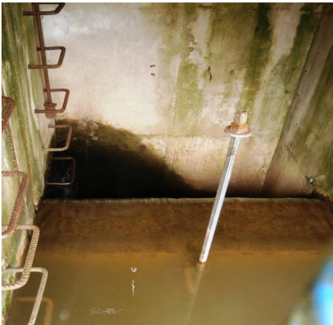
Obrázek 15 – Odtok vody požerákem.
