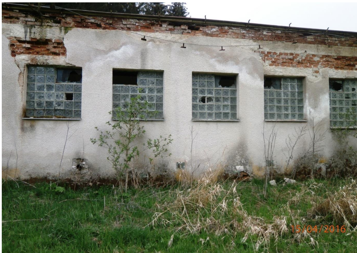
Obrázek 23 – Budova odběrného objektu.
