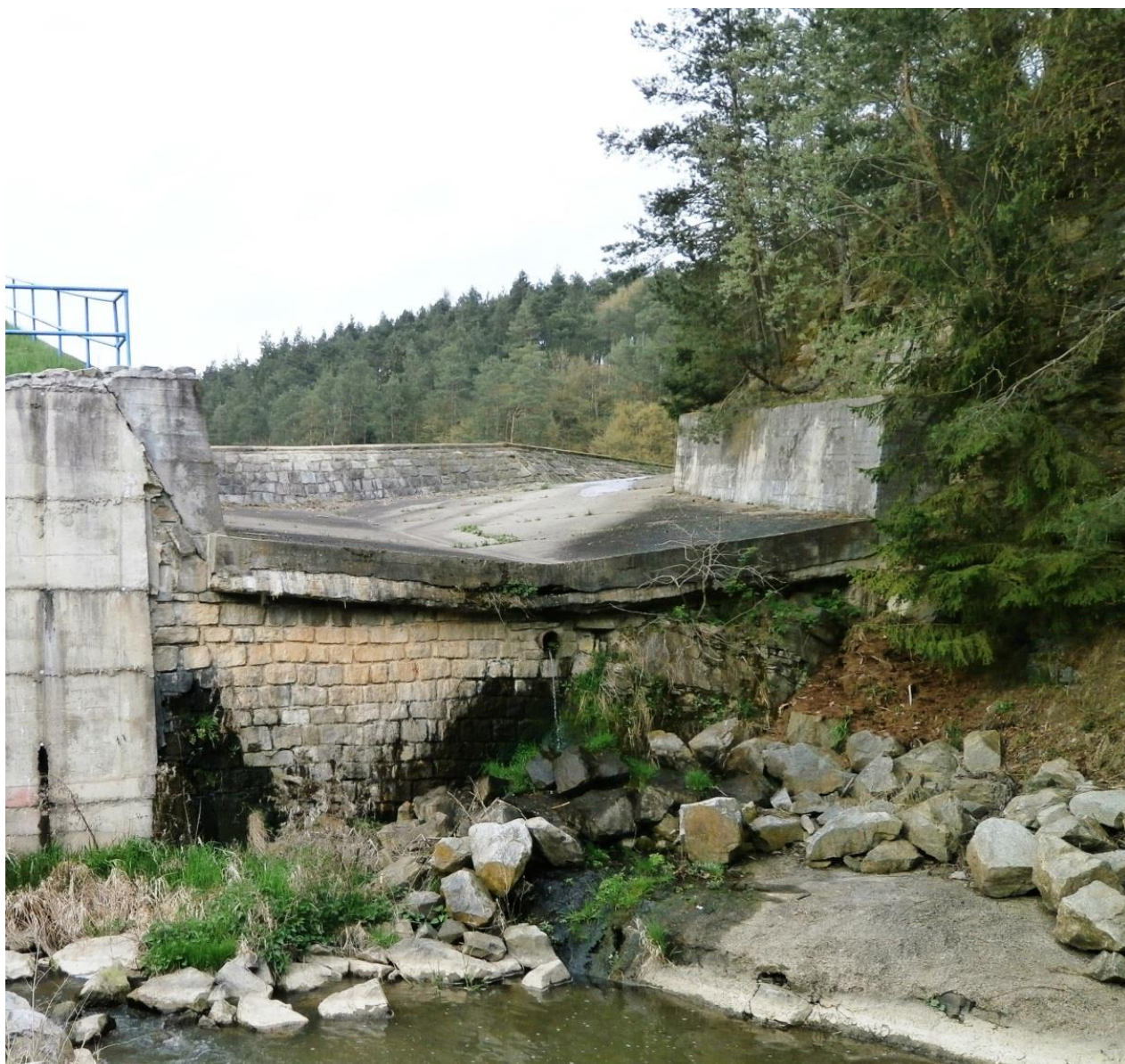
Obrázek 12 – Skluz a vývar pod bezpečnostním přelivem.
