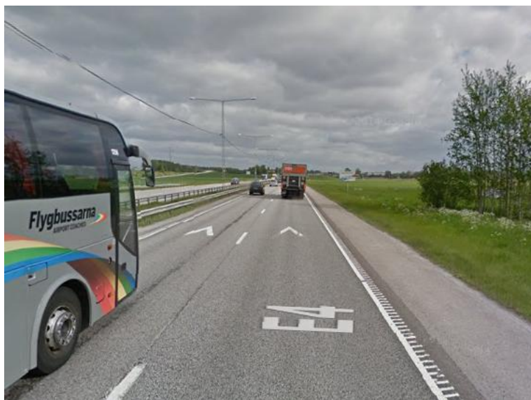
Obrázek 4.4 Vodorovné dopravní značení na švédské dálnici E4 mezi Upplands Väsby a letišťem Arlanda (Google.maps)
