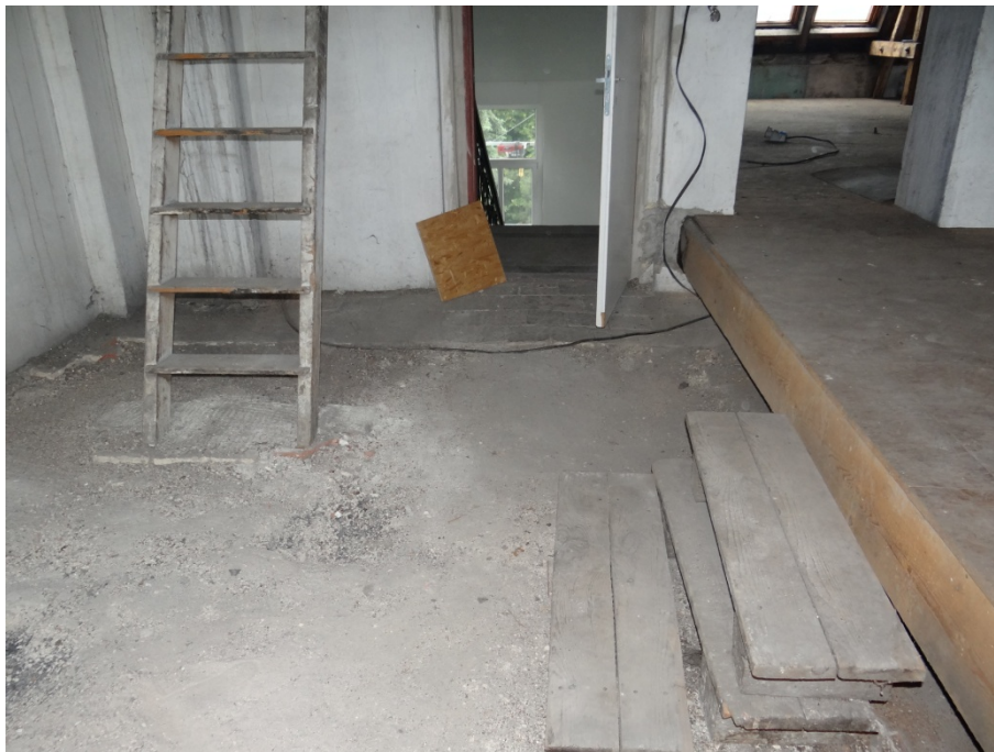
Obr. 1. 11 Vyvýšená podlaha v podkroví
