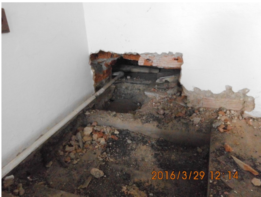
Obr. 1. 8 Sonda stropu pro zjištění skladby a stavu stropní konstrukce
