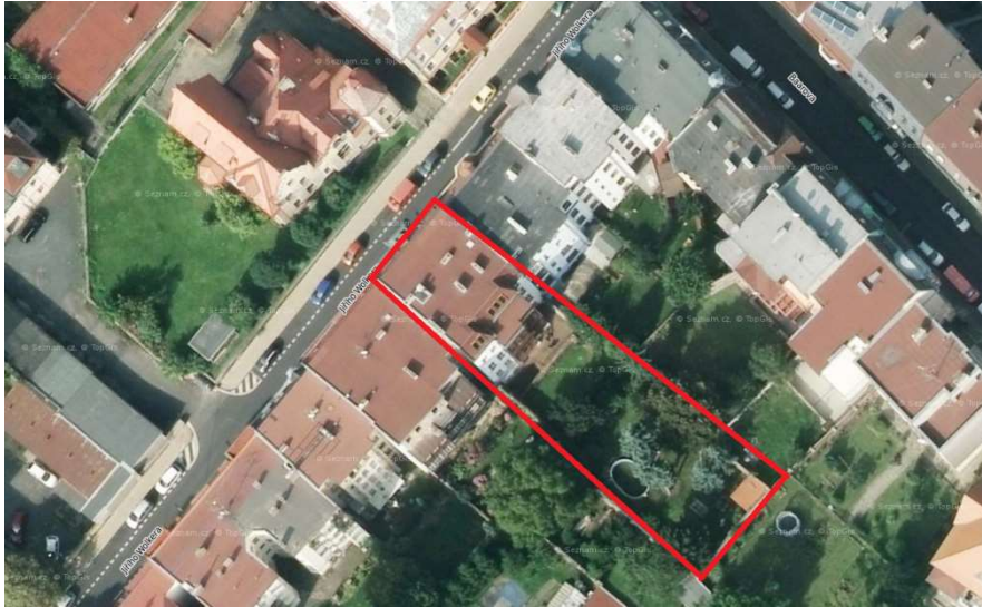
Obr. 1.7 Situační umístění objektu- letecký pohled (Zdroj: mapy.cz)
