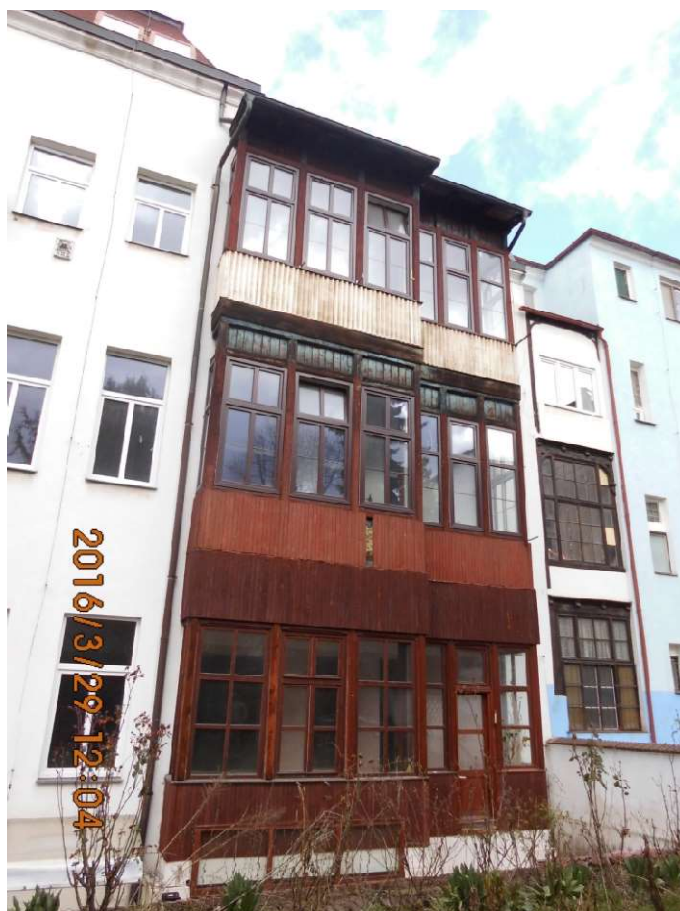
Obr. 1. 12 Foto zadní části fasády do dvora s lodgií
