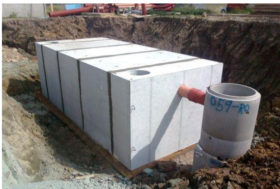
Obr. A 7 Železobetonová akumulční nádrž [9]
