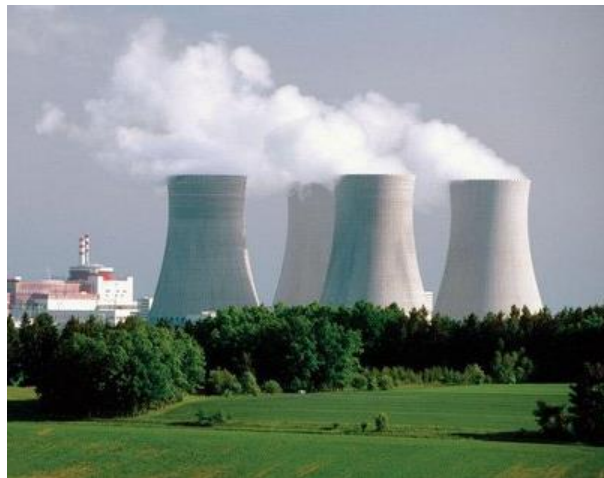
Obr. A 1 Jaderná elektrárna Temelín [4]
