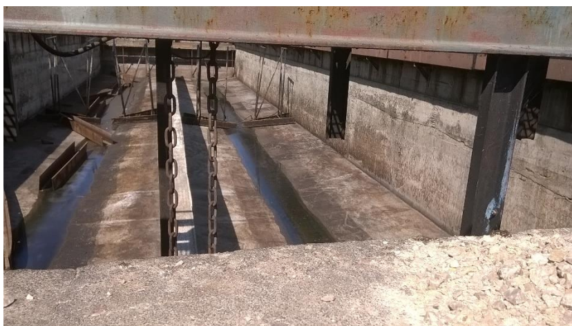
Obr. 44 – Jenda z dvoch pôvodných usadzovacích nádrží [3]
