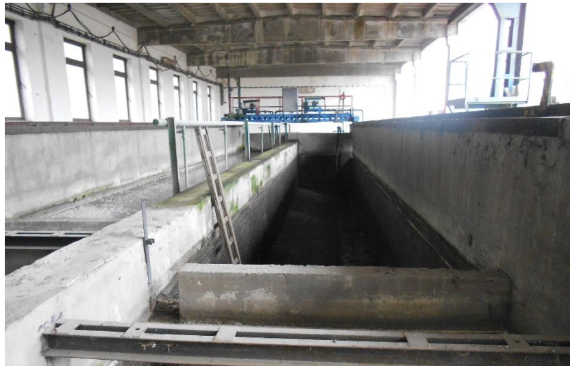
Obr. 41 - Dva pôvodné totožné lapače piesku [3]
