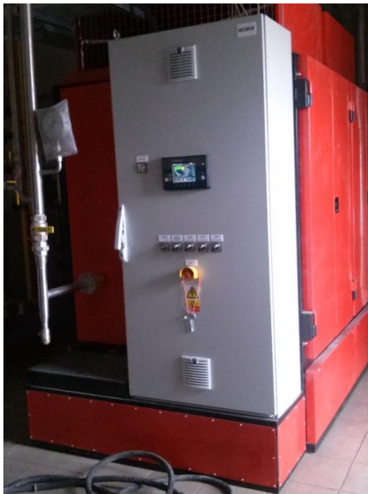
Obr. 60 - Kogeneračná jednotka [4]
