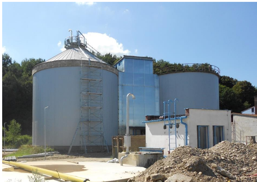
Obr. 55 - Vyhívacia nádrž (vľavo) a uskladňovacia nádrž (vpravo) [3]
