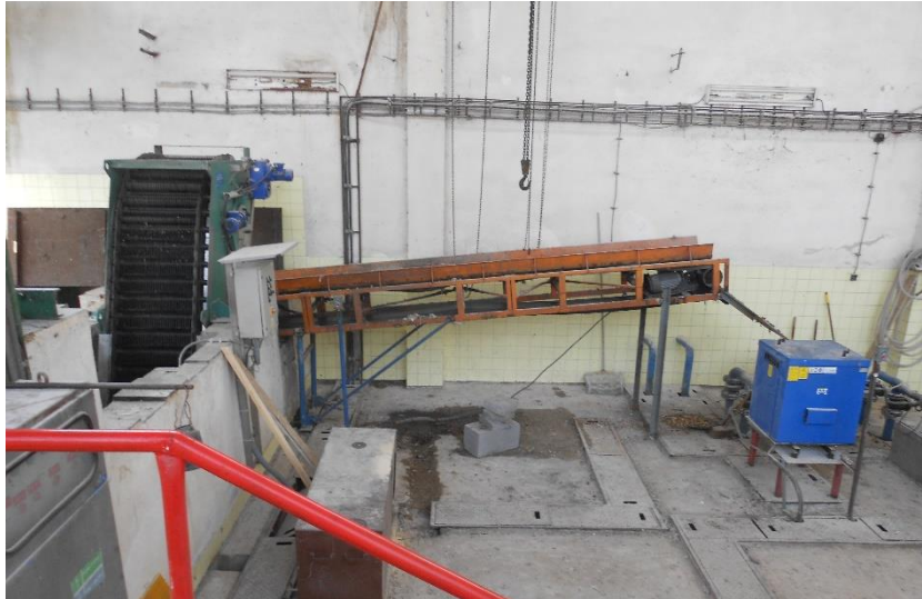
Obr. 38 - Původné DOOR hrablice [3]
