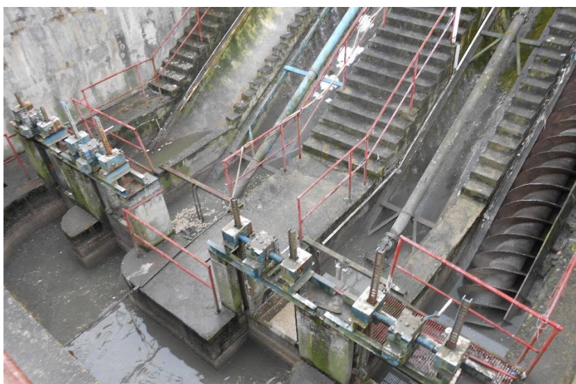
Obr. 35 - Sací bazén pred rekonštrukciou s pôvodnou čerpaciou stanicou [3]
