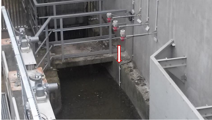
Obr. 62 - Tlakové čidlo na prítoku do ČOV [4]
