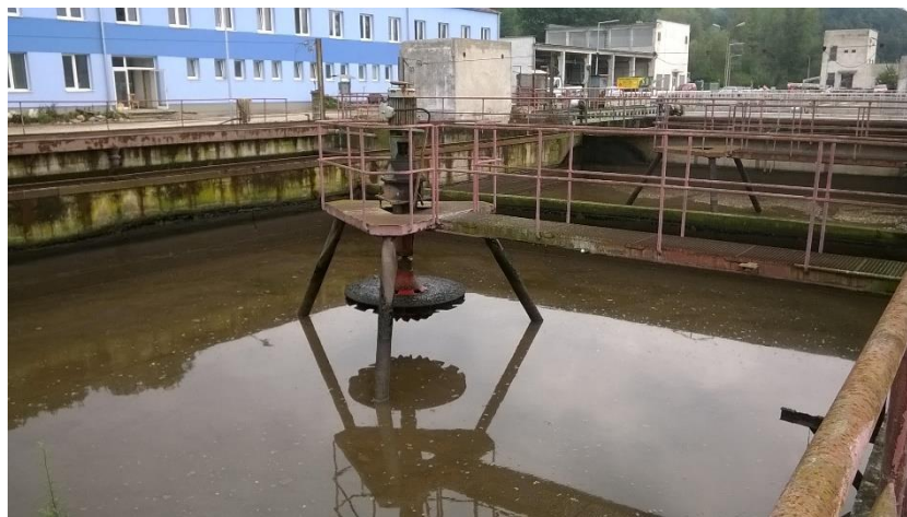
Obr. 47 - Mechanické aerátory používané pred rekonštrukciou [3]
