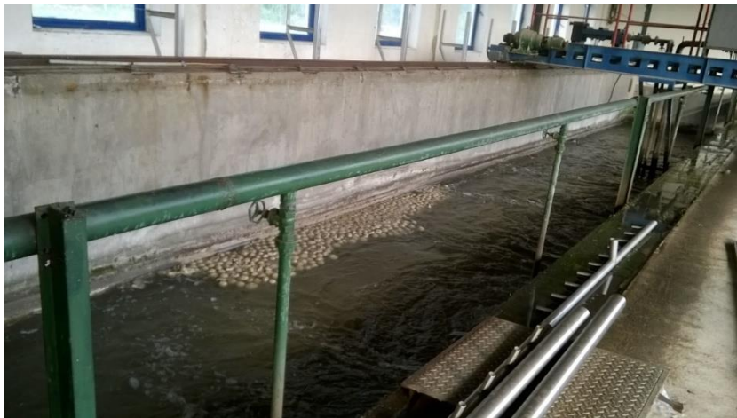
Obr. 65 - Zanesená hladina lapača piesku [3]
