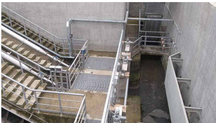
Obr. 36 - Zrekonštruovaný sací bazén [4]
