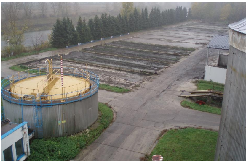
Obr. 58 - Pôvodné kalové polia na mieste súčasných dosadzovacích nádrží a pôvodný plynojem [3]
