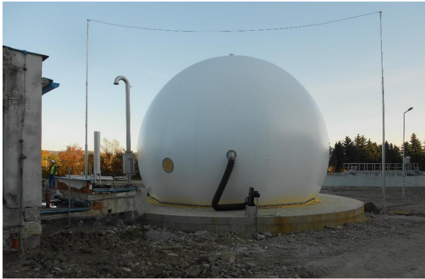
Obr. 59 - Nový dvojmembránový plynojem a horák zvyškového plynu [3]
