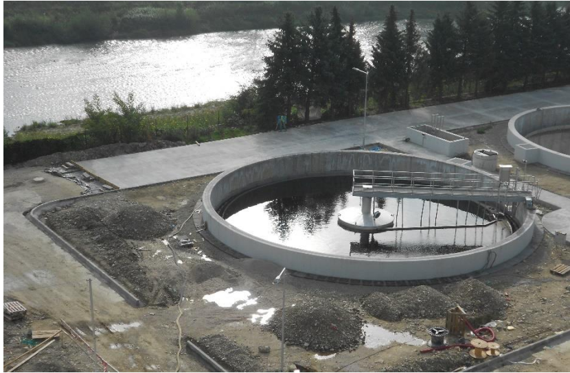
Obr. 51 - Jedna z novovybudovaných dosadzovacích nádrží [3]
