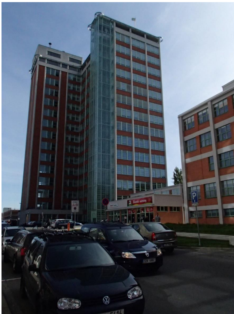
Obrázek 1 - Fotka: Současná podoba Správní budovy firmy Bata [autor: doc. Ing. Pavel Svoboda, CSc]
