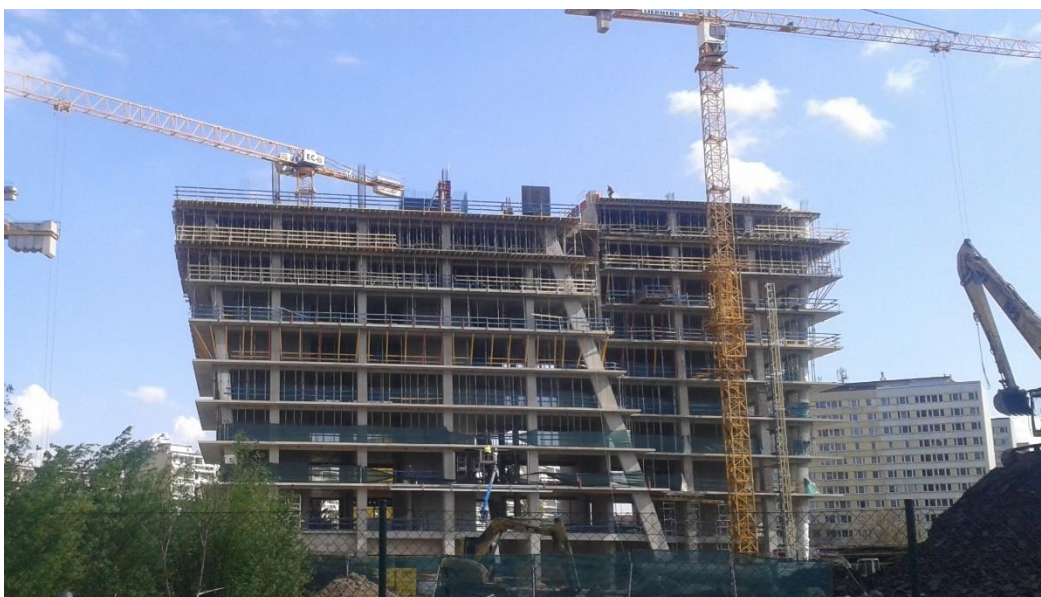
Obrázek 15 - Fotka: Objekt V Tower ve fázi realizace [autor: Lukáš Brotánek]
