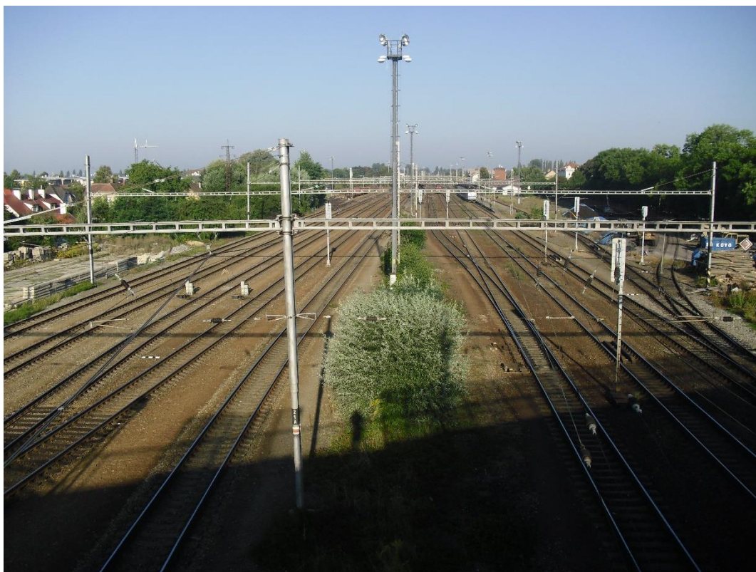
Obrázek 9. Pohled z nadjezdu
