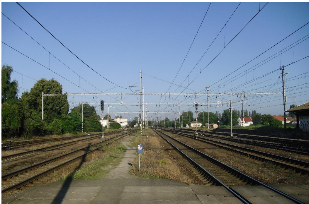
Obrázek 8. Pohled z druhého nástupiště na západní část stanice
