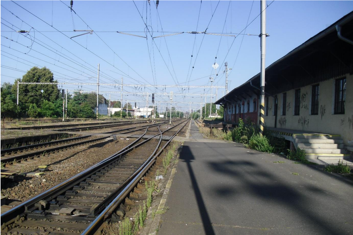
Obrázek 13. Kolej č. 4a s úrovnňovým nástupištěm IA
