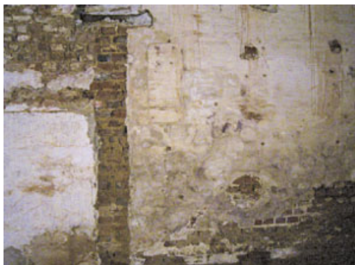
Obrázek 5: Porucha omítky vlivem krystalizace solí [34]
