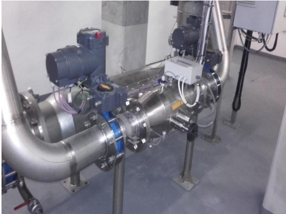
Obrázek 29: Nová UV lampa - v pozadí, původní UV lampa - v popředí (zdroj: archiv Vodovody a kanalizace Vsetín a.s.)
