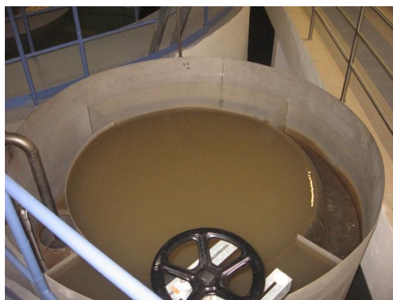
Obrázek 17: Rozdělovací objekt před rekonstrukcí (zdroj: archiv Vodovody a kanalizace Vsetín a.s.)
