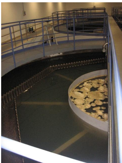
Obrázek 21: Sedimentační nádrže - pohled od filtrů
