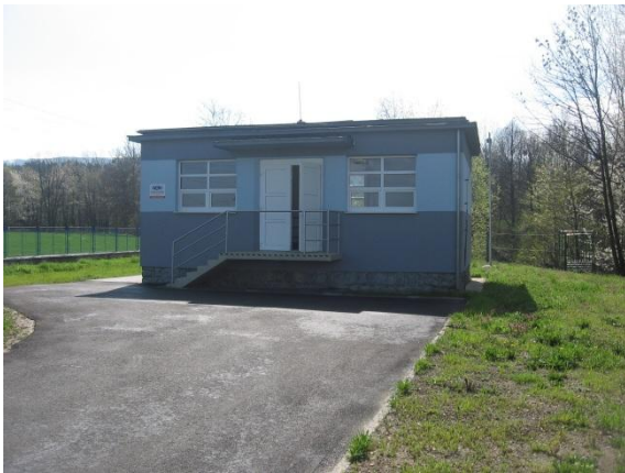
Obrázek 11: Objekt čerpací stanice
