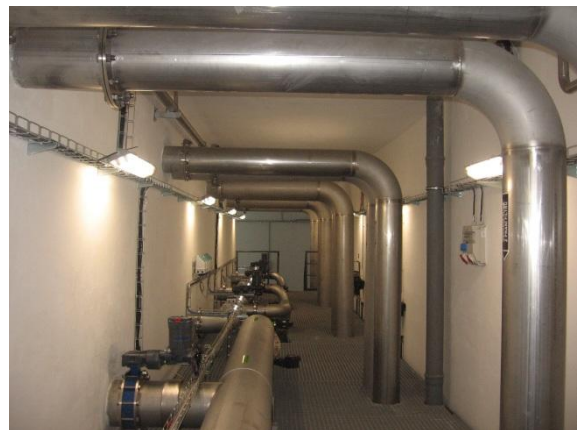
Obrázek 25: Přítok prací vody na filtry, přívod pracovního vzduchu, přívod odsazené vody ze sedimentace
