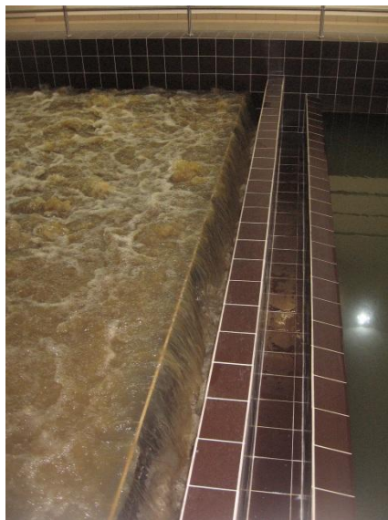
Obrázek 27: Výstavba nového otevřeného rychlofiltru pro GAU (zdroj: archiv Vodovody a kanalizace Vsetín a.s.)
