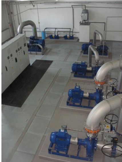
Obrázek 13: Čerpadla pro výtlač do VDJ, prací čerpadla a evakuační stanice
