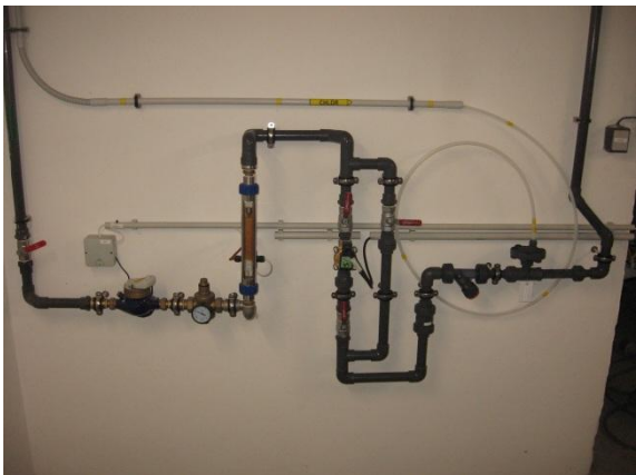
Obrázek 31: Dávkování chlorové vody do upravené vody za UV lampami
