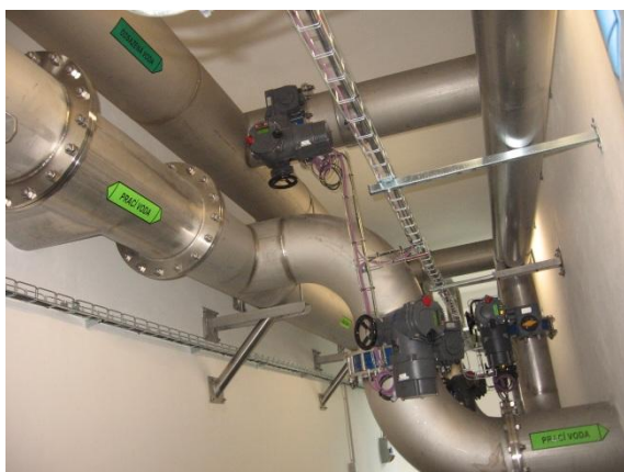
Obrázek 19: Horní potrubí - odtok odsazené vody ze sedimentace na filtraci, dolní potrubí - přívod prací vody na filtry
