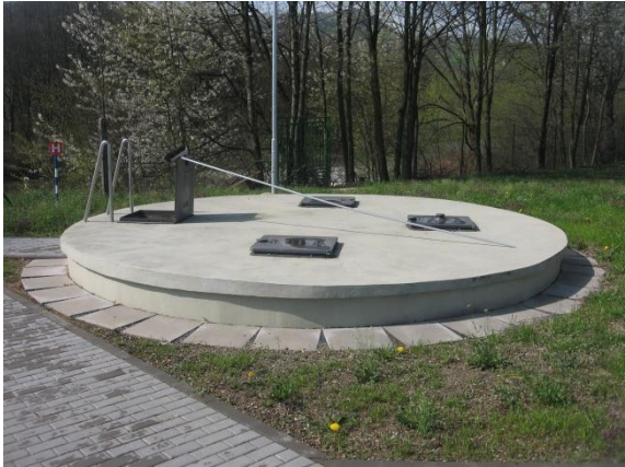
Obrázek 9: Objekt jímky surové vody
