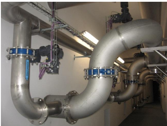
Obrázek 25: Přítok prací vody na filtry, přívod pracovního vzduchu, přívod odsazené vody ze sedimentace
