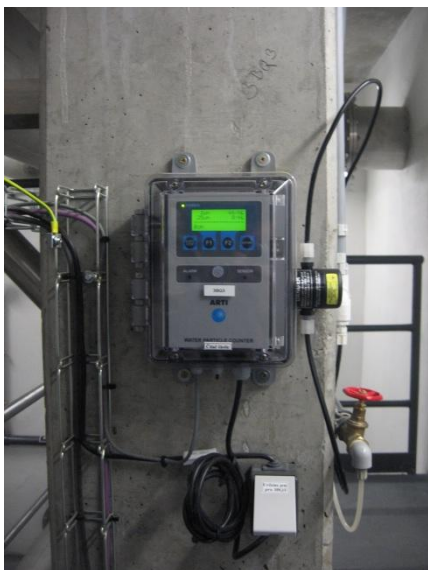
Obrázek 39: Čítač pevných částic za GAU filtry
