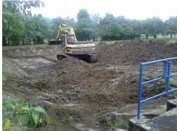
Obrázek 36: Čištění kalové laguny (zdroj: Vodovody a kanalizace Vsetín a.s.)
