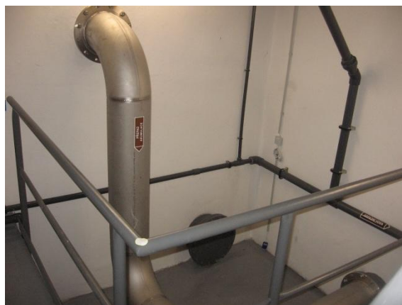
Obrázek 34: Přepad z akumulační nádrže a původní zaslepené potrubí z akumulační nádrže
