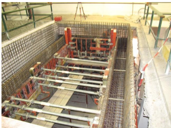
Obrázek 27: Výstavba nového otevřeného rychlofiltru pro GAU (zdroj: archiv Vodovody a kanalizace Vsetín a.s.)
