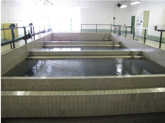
Obrázek 23: GAU filtry před rekonstrukcí
