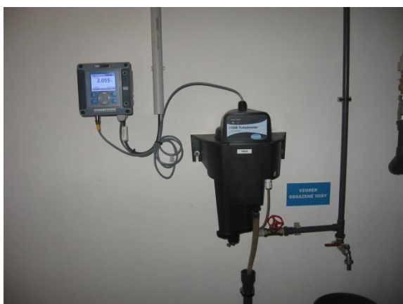
Obrázek 41: Odběr vzorku odsazené vody sedimentací, turbidimetr pro měření zákalu za sedimentací
