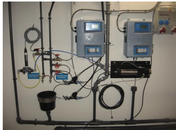
Obrázek 32: Měření absorbance 254 nm před dávkováním chloru, měření koncentrace \text{Cl}_2 , teploty a pH po dávkování chloru
