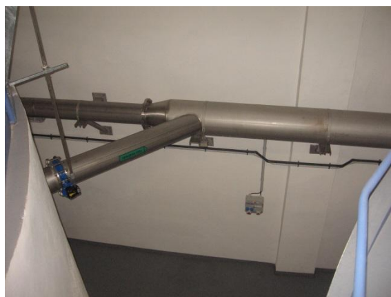
Obrázek 19: Horní potrubí - odtok odsazené vody ze sedimentace na filtraci, dolní potrubí - přívod prací vody na filtry
