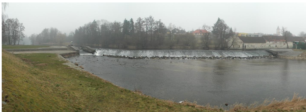
Obrázek 22 Pohled na jezové těleso v Katovicích (Průzkum)
