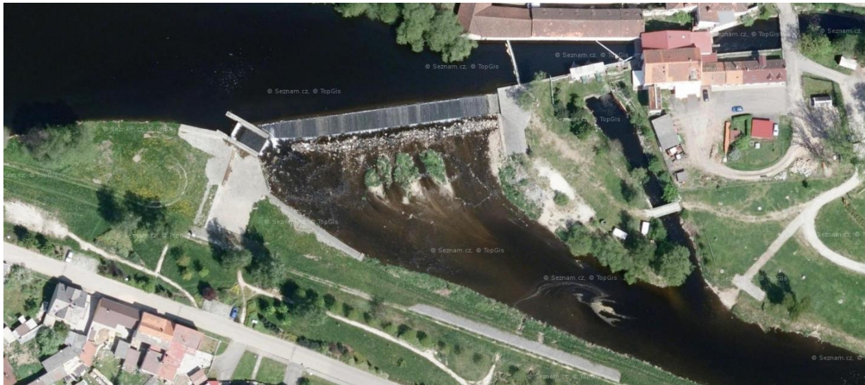
Obrázek 20 Letecký snímek jezového tělesa v Katovicích (9)
