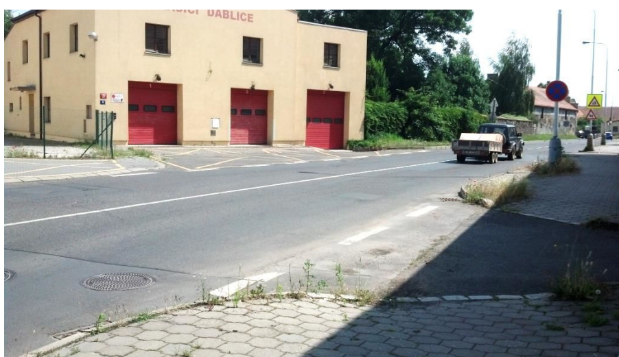
Obr. 22: Místo k přecházení a hasičská budova (zdroj: archiv autora)
