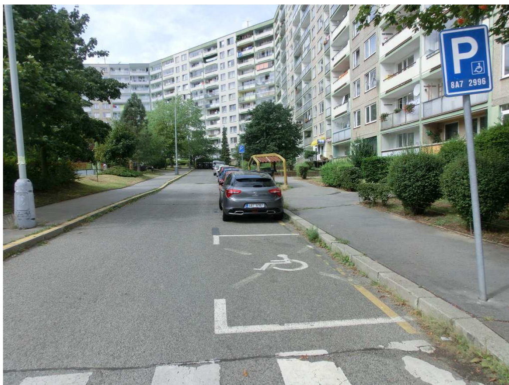
Obrázek 6 - Chybně provedené DZ v ulici Brdičkova
