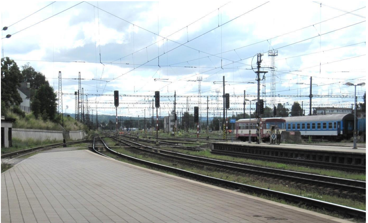
Obrázek A.3: Pohled na brněnsko-olomoucké zhlaví s odstavenými vozy na kolejích č. 3a a 4a
