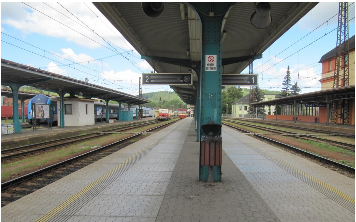
Obrázek A.12: Zrekonstruované nástupiště II.
