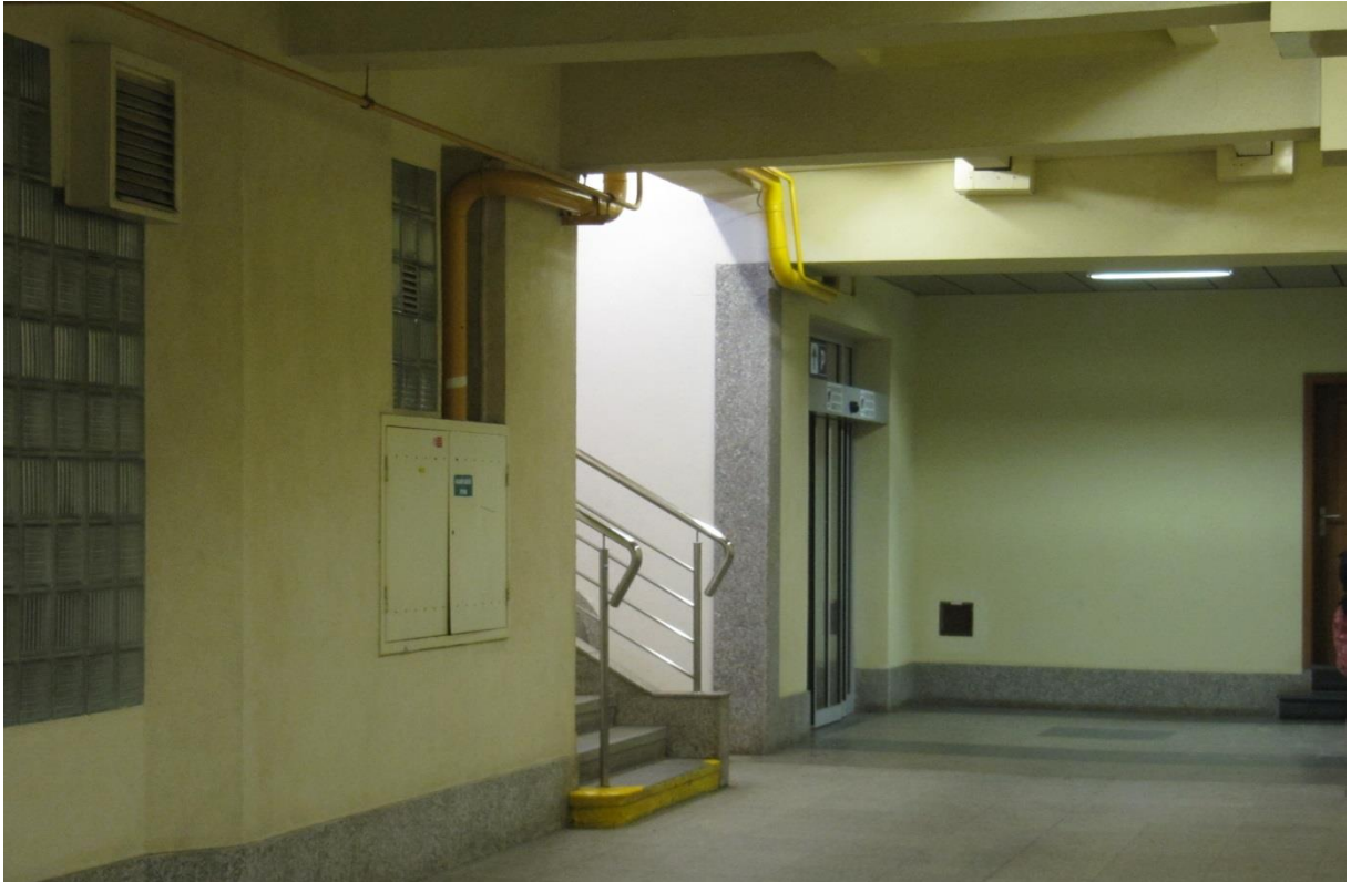
Obrázek A.19: Schodiště z podchodu do odbavovací haly VB a přístup do podzemní garáže
