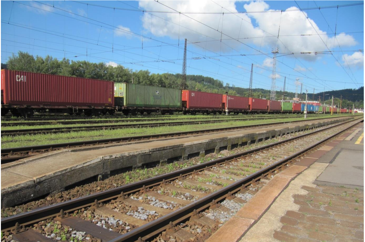
Obrázek A.9: Část zpevněného úrovněového nástupiště V.
