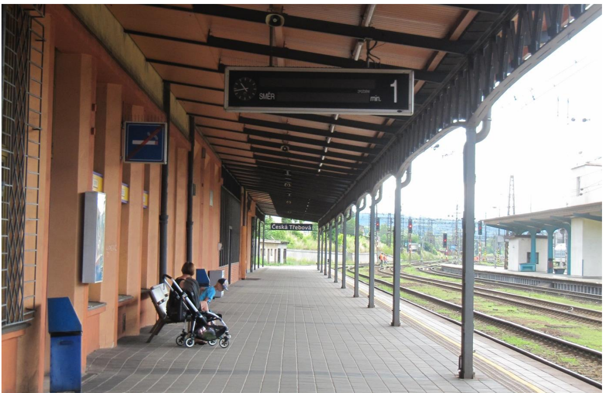
Obrázek A.14: Pohled na zvlňené nástupiště I. směrem k brněnsko-olomouckému zhlaví
