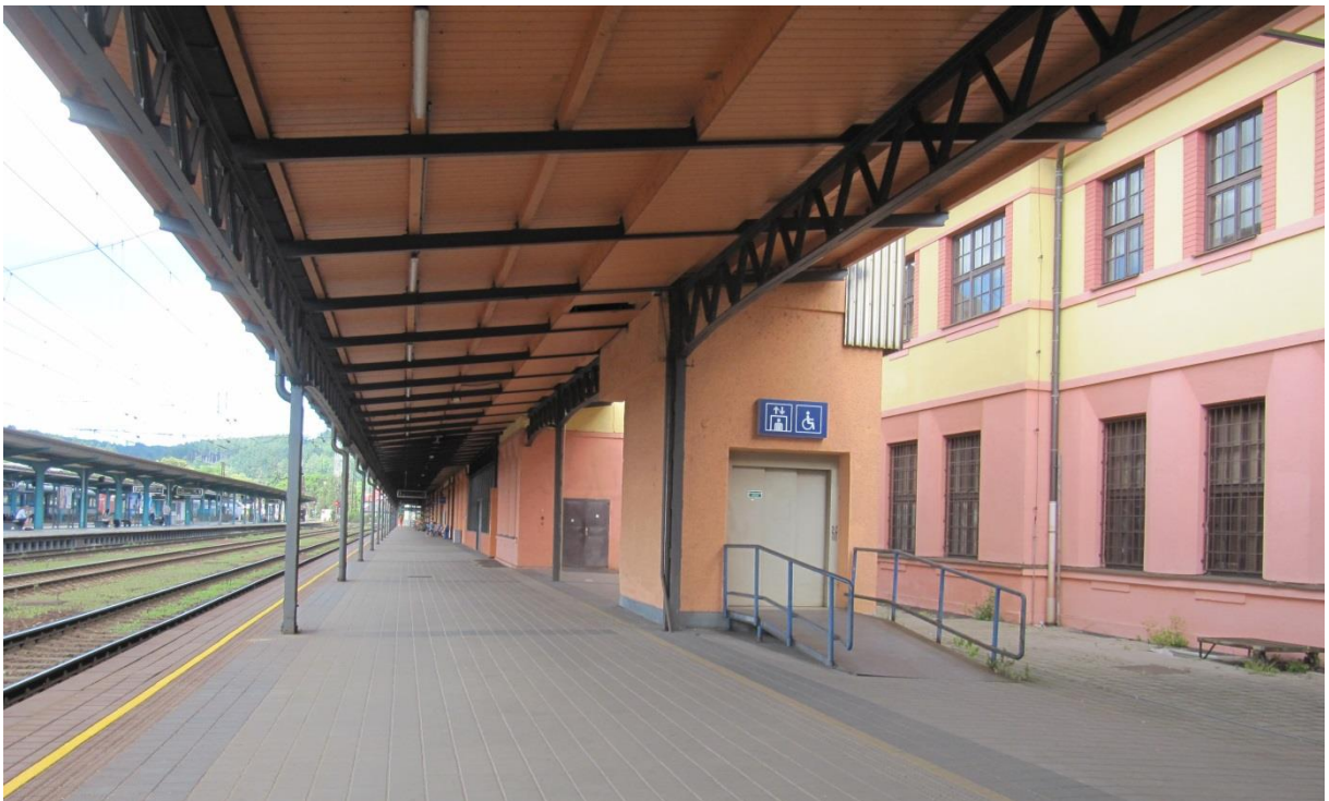
Obrázek A.16: Odsazené zdvihací zařízení na nástupišti I.
