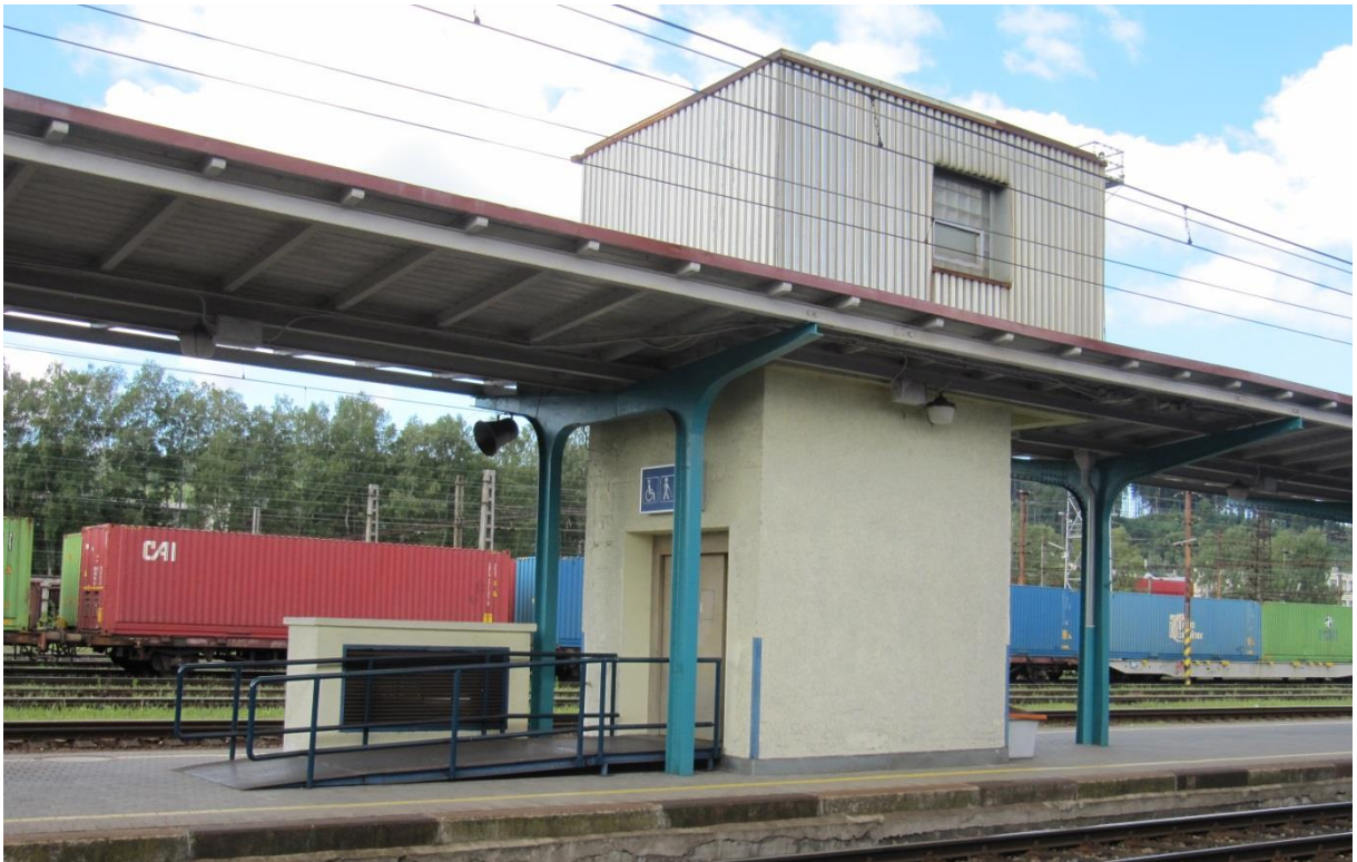
Obrázek A.15: Zdvihací zařízení na nástupišti IV.
