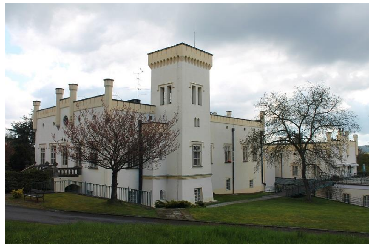
Obrázek 12: Pohled na zámek Leontýn – krajinný prvek s číselným označením 26; [zdroj: M. Petýrek, 2016]
