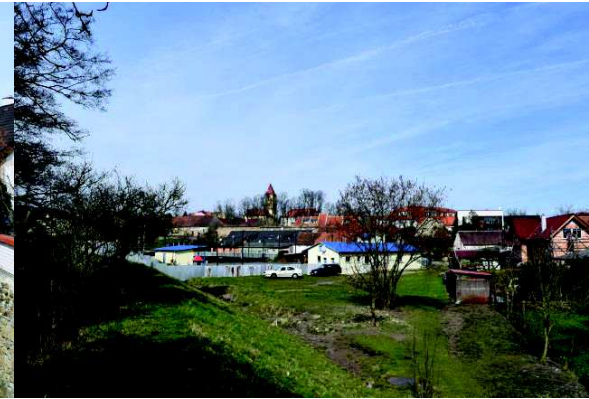
Obr. 28) pohled na sportovní areál ze zemní hráze
