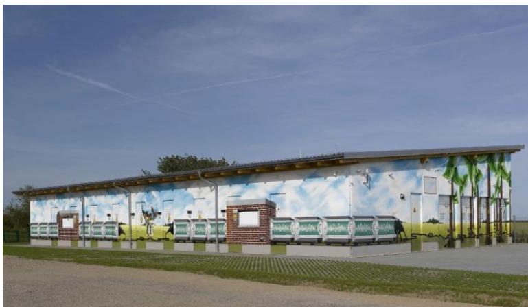
Obrázek č.26 – pohled na bateriové úložiště v německém Feldheimu
