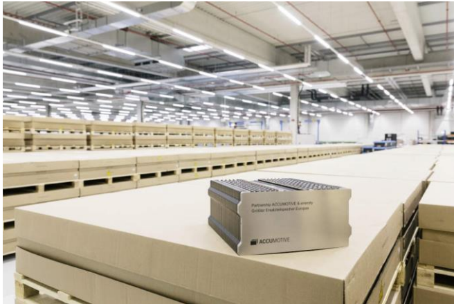
Obrázek č.25 – pohled na použitý exemplář baterie v ještě rozestavěném centru v Hannoveru
