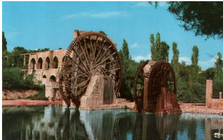
Obr. 1 - Vodní kolo jako prostředek k čerpání vody do zavlažovacího systému, Sýrie, pozdní středověk [1]
