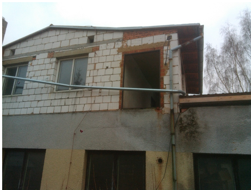
Obr. č. 2 Pohled na nedokončený vstup do horních bytů
