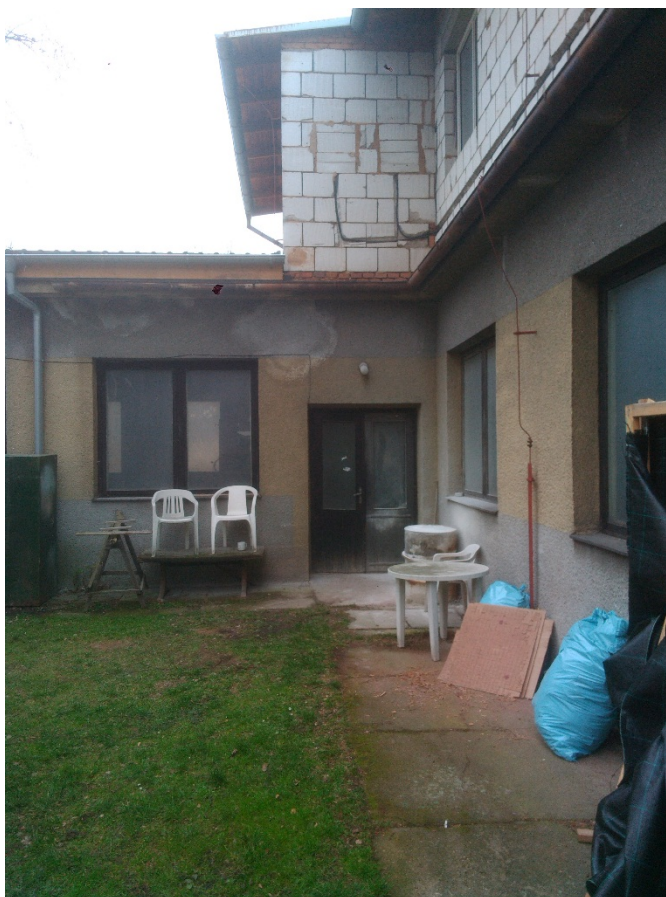
Obr. č. 1 Pohled na vstup do objektu
