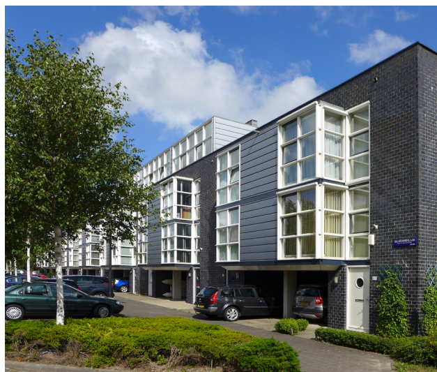
Obr. 3.4 - 14 Způsob řešení parkování bezprostředně ovlivňuje charakter veřejného prostoru a jeho živost, příklad krytých stání v objektu (NL)
