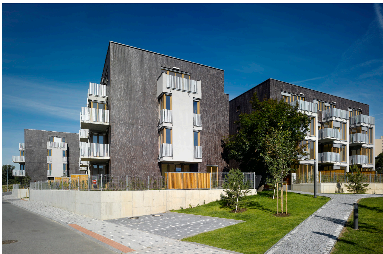
Obr. 2.1 - 7 Fotografie venkovní hrany obytného souboru Na Vackově ve vztahu k veřejnému prostoru, materiál fasády má reprezentativní charakter (foto Filip Šlapal)
