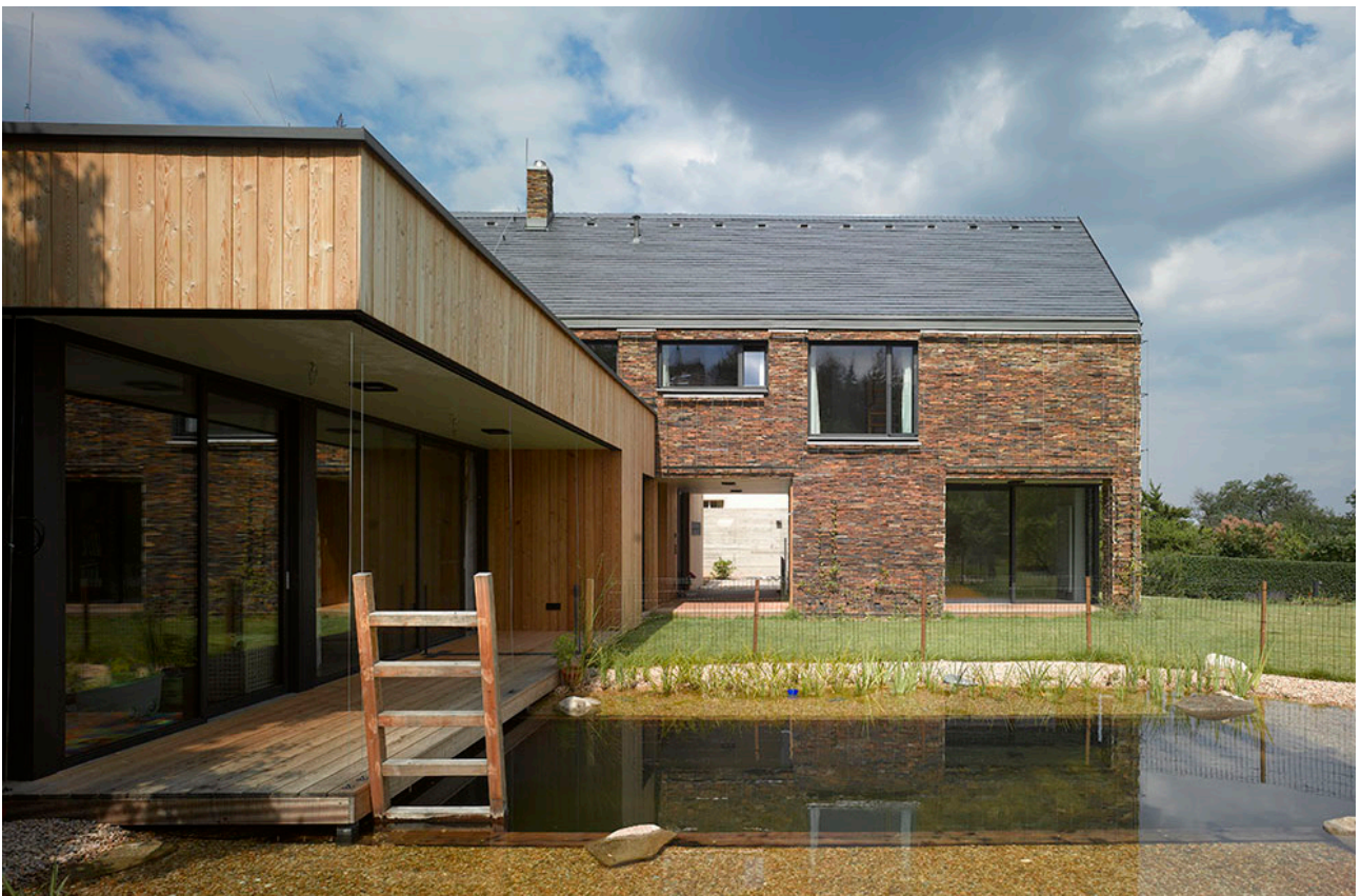
Obr. 2.2 - 2 Fotografie rodinného domu ve Vonoklasech ze strany přírodního koupacího jezírka (foto Filip Šlapal)
