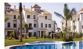
obytný resort, Costa del sol, Španělsko
