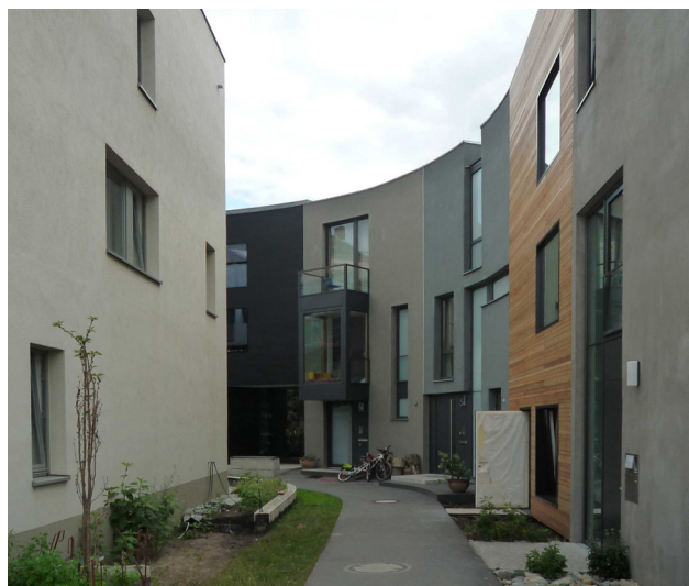
Obr. 3.4 - 9 Společné parkování je umístěno mimo uličku, ta slouží pouze pro pohotovostní předjezd, výsledkem je příjemné místo s lidským měřítkem (Berlin, DE)
